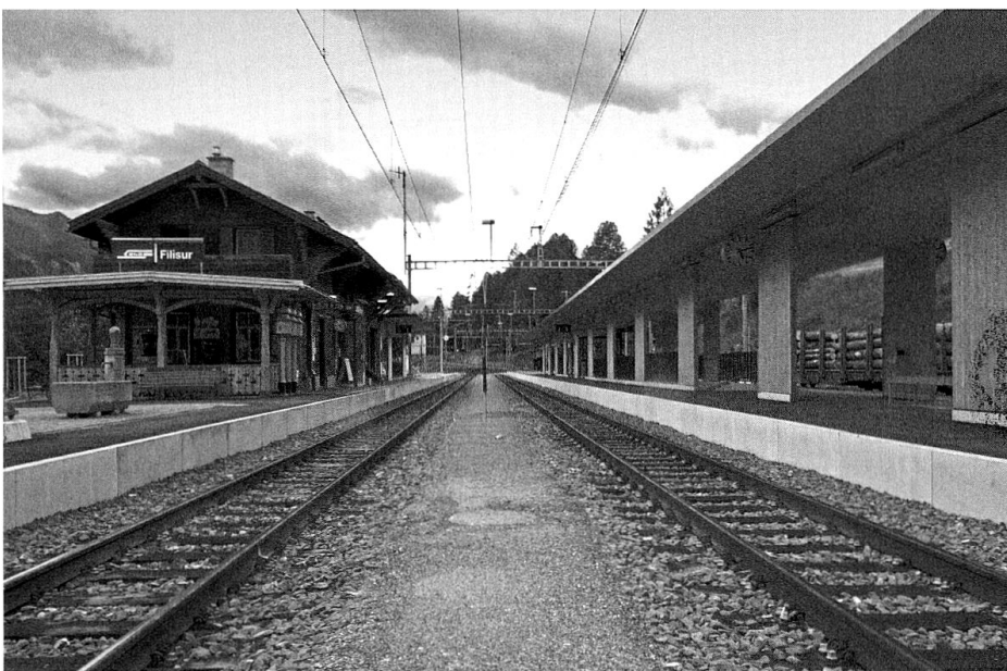
Bahnhof Filisur mit der neuen Perronanlage.
