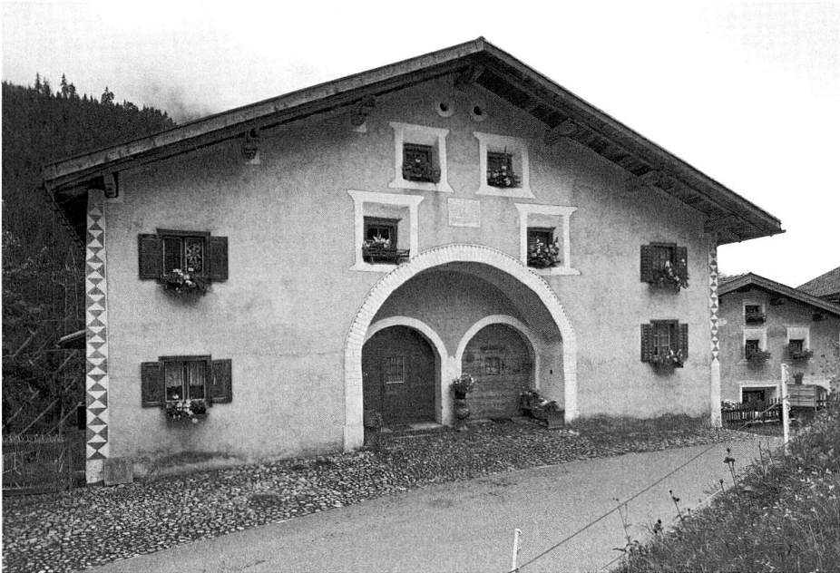
Doppelhaus Nr. 7 (Ambühl) mit mächtiger Rundbogen- nische.
