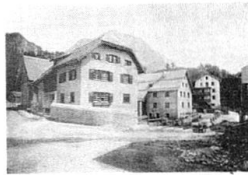
NEUE BAUERNHÄUSER IN TAMINS (nach dem Brande). Erbaut nach den Plänen der Architekten Alfred Schäfer und Alb. Hartmann in St. Moritz. UNE FERME MODERNE A TAMINS. D'après les plans des architectes Alfr. Schäfer et Hartmann à St. Moritz.
