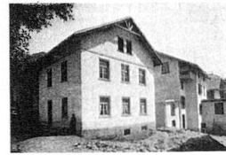
NEUE BAUERNHÄUSER IN TAMINS (nach dem Brande). Erbaut nach der Initiative unschöner Schablonen. FERME BANALE A TAMINS.
