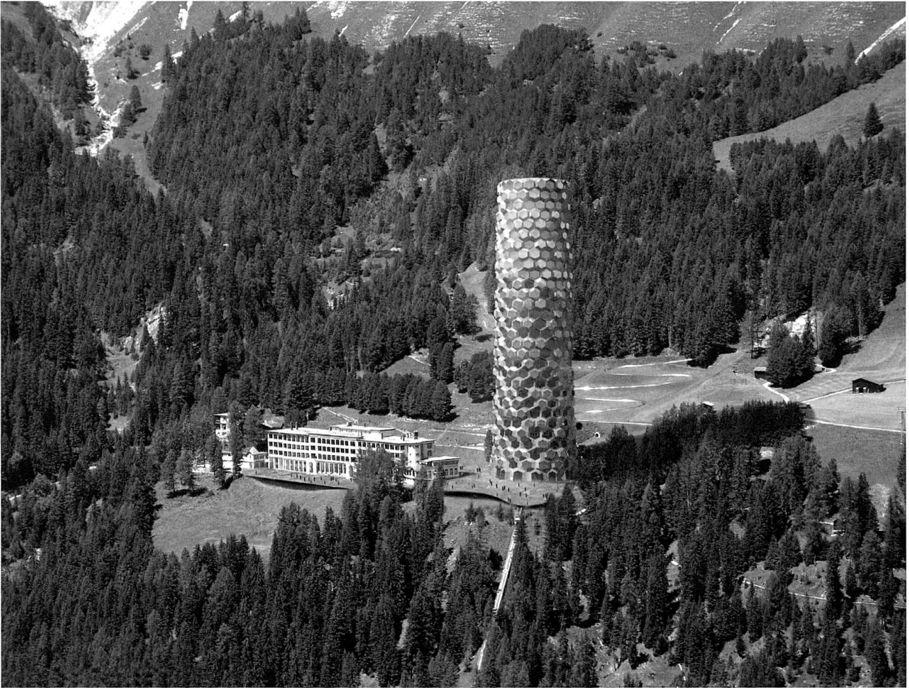
Das Turmprojekt von Herzog & de Meuron auf der Schatzalp (Foto: Schatzalp; www.schatzalp.ch , © Herzog & de Meuron)
