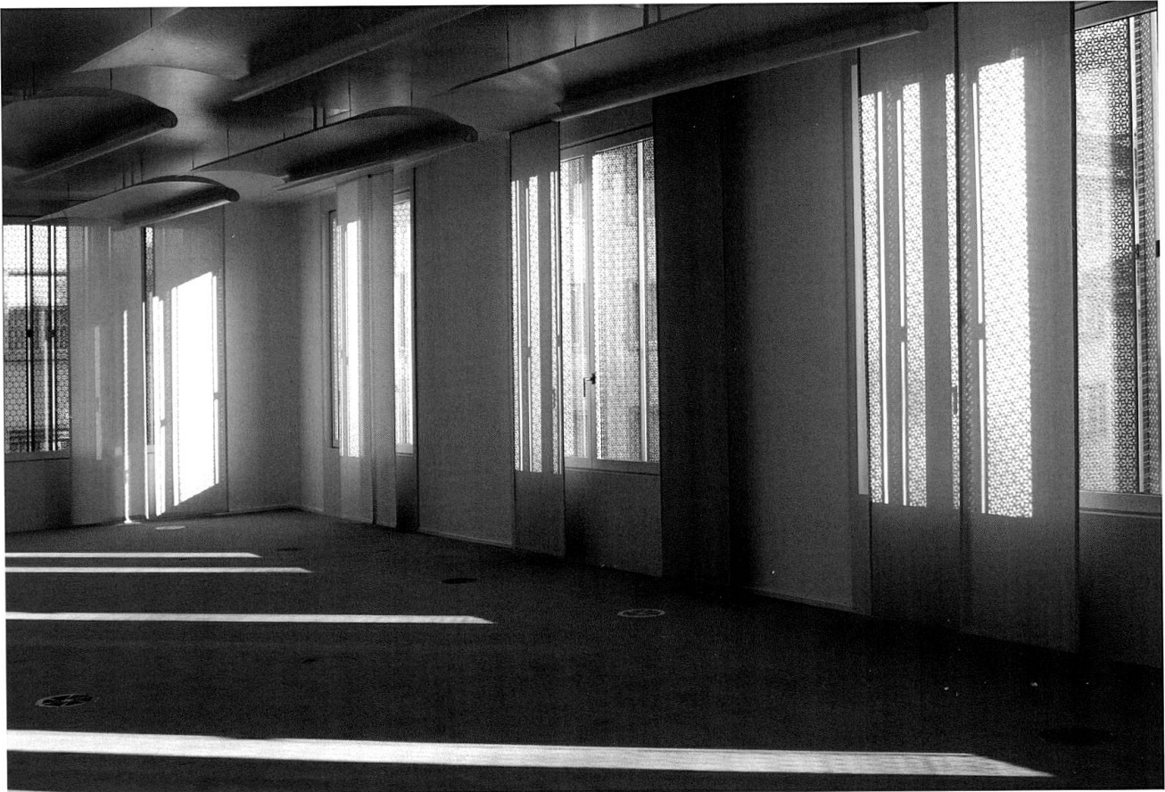
Die perforierten Fensterläden und die farbigen Vorhänge filtern in den Büros des Sonnenlicht.
