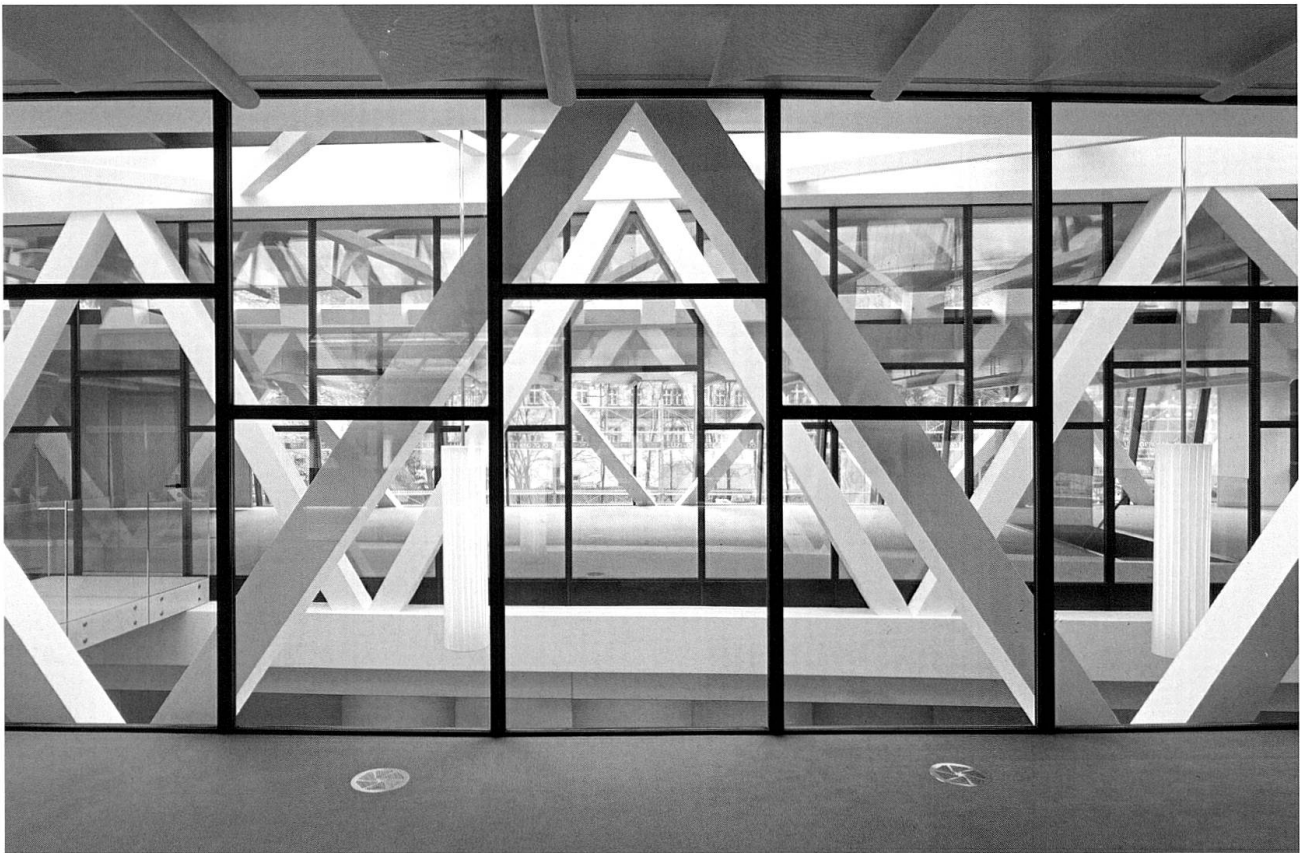
Im 1. Obergeschoss der Kundenhalle ergeben Glaswände und Fachwerkträger eine spektakuläre Transparenz.
