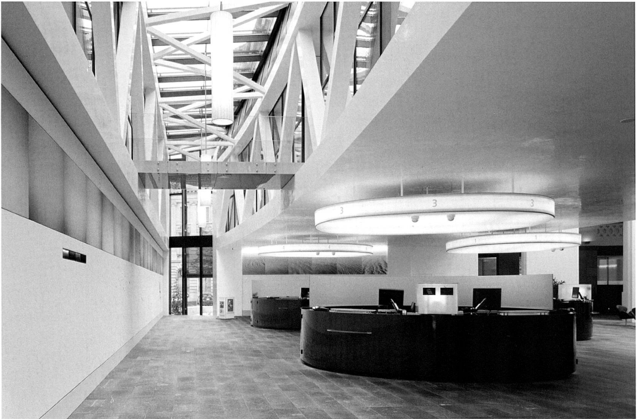
Gewaltige Betonfachwerkträger überspannen stützenlos die Kundenhalle.
