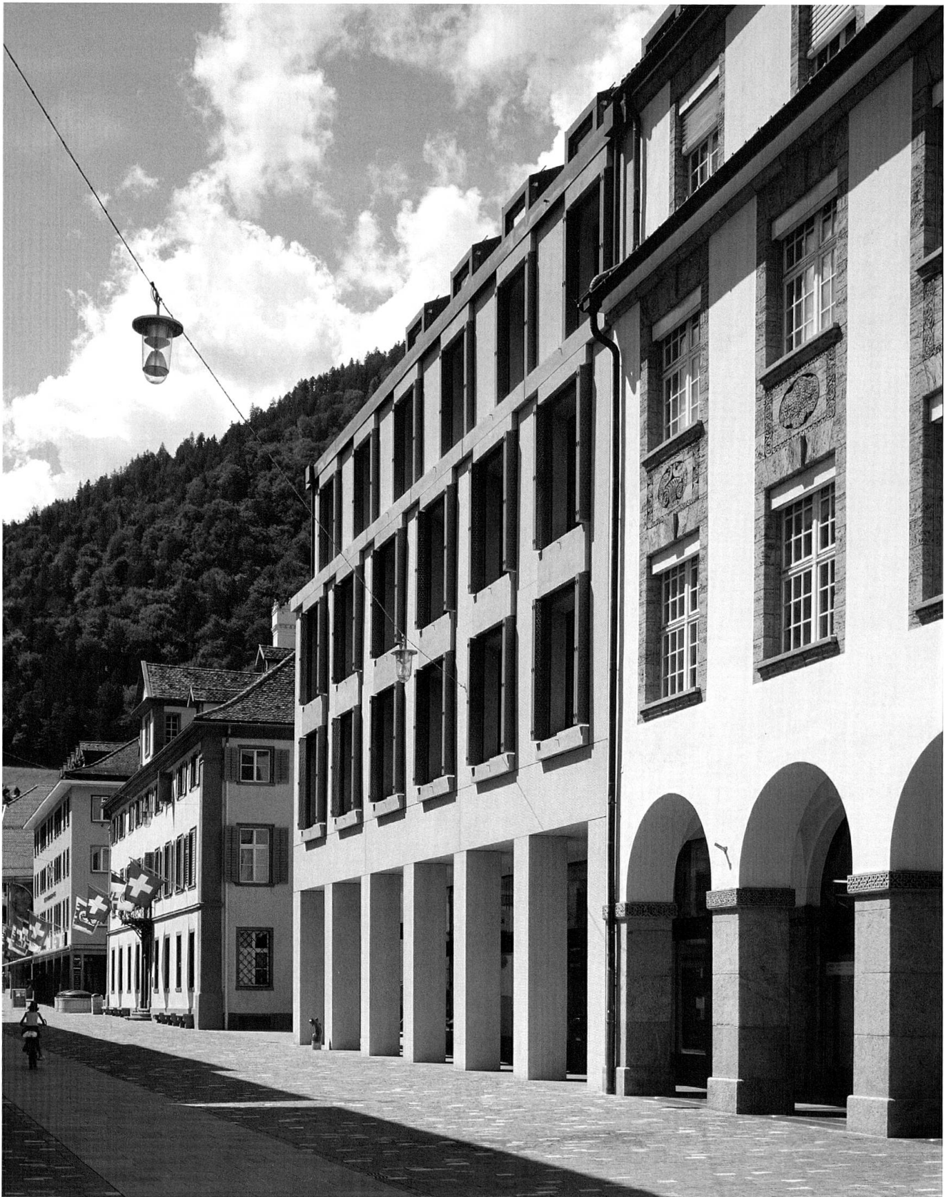
Hauptmerkmale des Gebäudes von Schäfer & Risch aus dem Jahre 1911 wie der Rhythmus der Fensterachsen, die Tektonik der Gewände und Gesimse sowie die Laube im Erdgeschoss sind weitergeführt.
