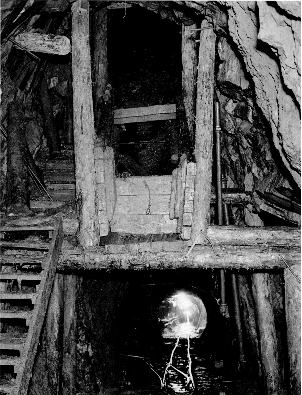
Baustelle Nalps, 15.5.1959: Oben Wasserschloss-Schrägschacht nach Ausführung des Vortriebsstollens, unten Druckstollen, aufgenommen in Richtung Nalps, mit Abzweigung nach links zum Fensterstollen.
