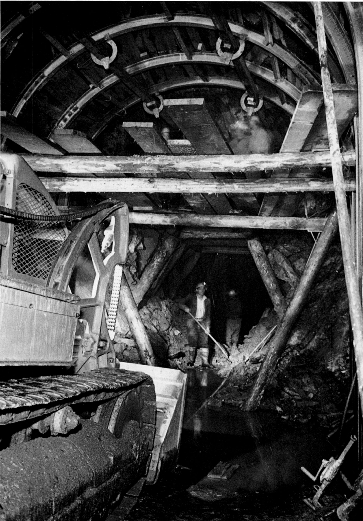
Baustelle Sedrun, 6.10.1958: Ausweitung des Zugangsstollens.
