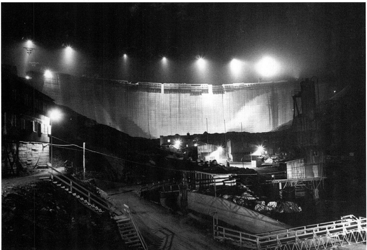
Baustelle Sta. Maria, 10.7.1967: Staumauer mit Barackendorf bei Nacht. Vorne Zufahrtsstrasse und Auslauf Grundablass Hochwasserentlastung.
