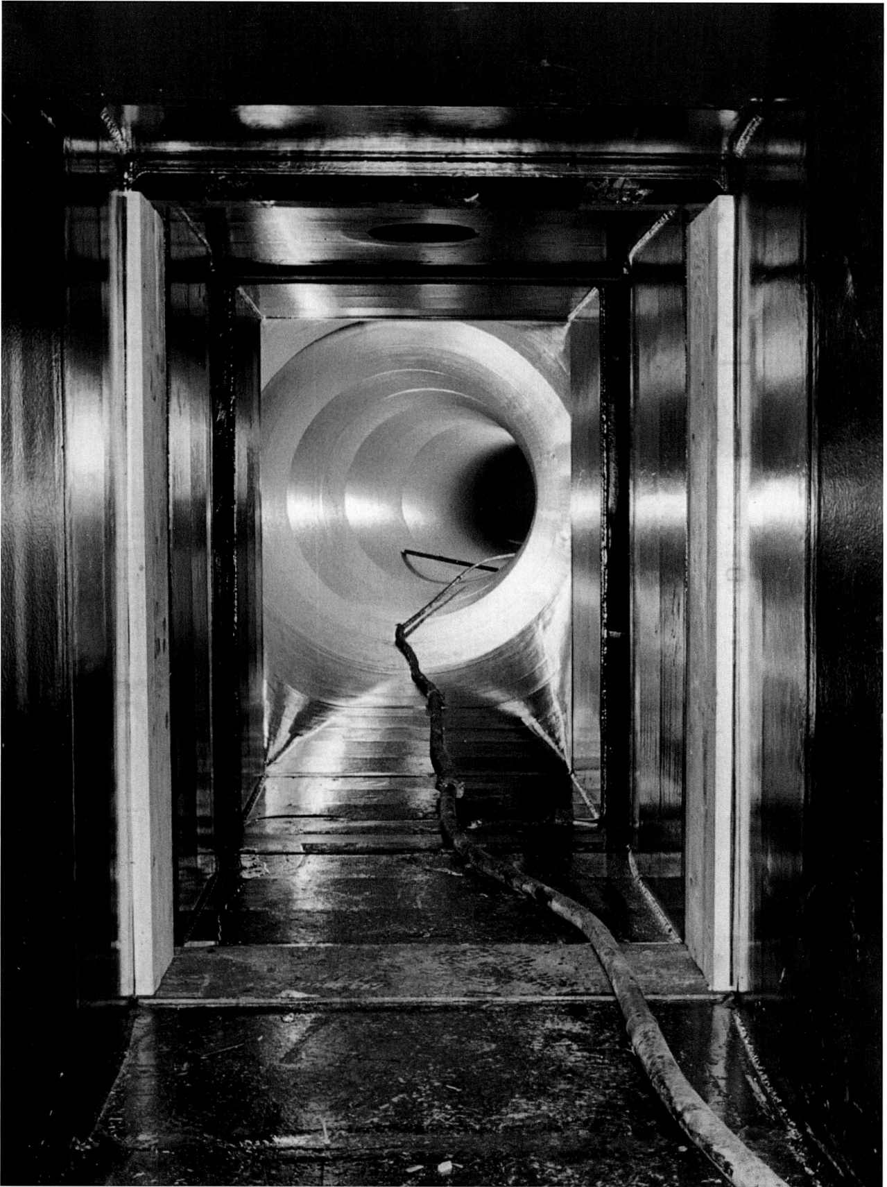
Baustelle Nalps, 15.5.1961: Grundablass. Ansicht durch die Schützen gegen den See.
