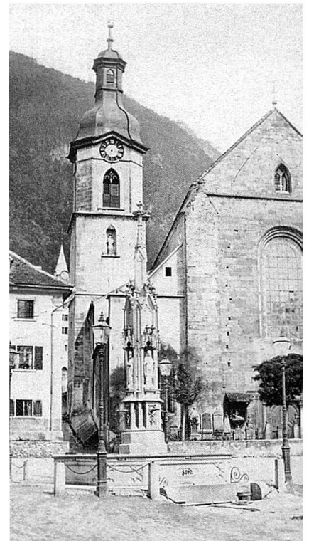
Die Gasse zwischen Kathedrale und Kustorei mit abgedecktem Entfeuchtungsgraben. Fotografie aus den 1860er Jahren. Blick nach Osten (Original im Rätischen Museum; Inv. Nr. H 1962.312).
