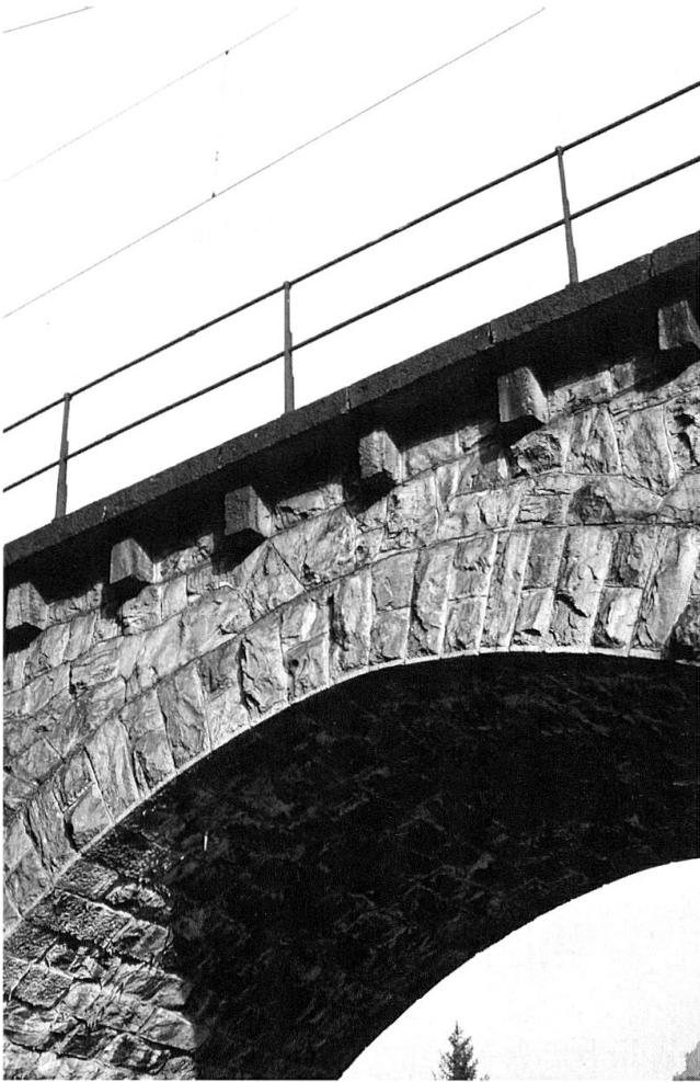
Albulastrecke. Detail der Mauerkrone des Solisviadukts (J. Conzett).
