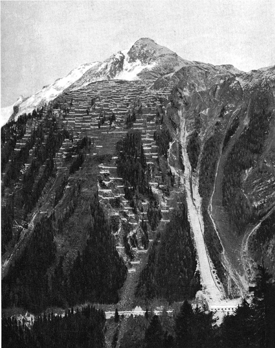
Albulastrecke. Die Lawinerverbauung Muot im Jahr 1907. Rechts unten die Chanaletta-Galerie (RhB).
