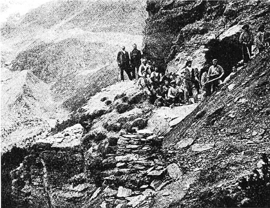
Tunnelbau an der Berninastrecke. Unteres Portal des Palütunnels während der Bauarbeiten (in: E. Bosshard. Die Berninabahn. Zürich 1912 [Schweizerische Bauzeitung, Sonderabdruck]).
