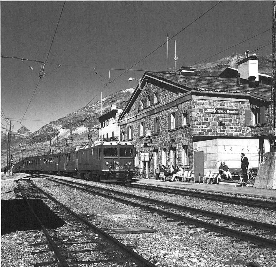
Berninastrecke. Aufnahmegebäude der Station «Ospizio Bernina» von 1925, Architekt Nicolaus Hartmann (A. Henkel).
