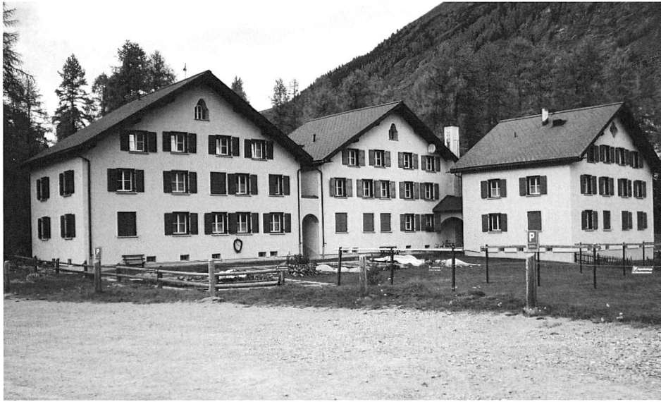
Die von Nicolaus Hartmann 1911 erbaute Eisenbahnersiedlung Cuntschett in Pontresina (L. Dosch).
