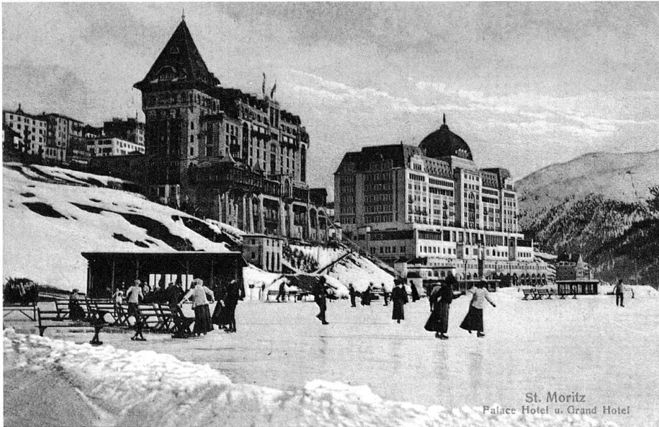
Hotel Palace (links) und Grand Hotel in St. Moritz Dorf, kolorierte Aufnahme um 1910 (Dokumentationsbibliothek St. Moritz).
