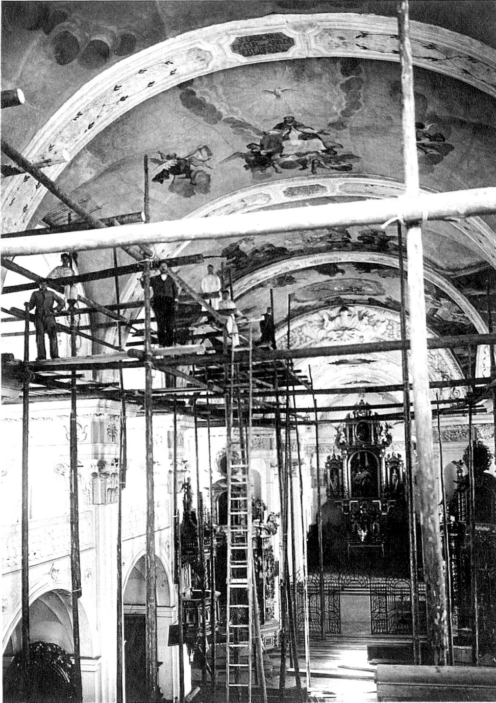
Aufnahme während der Renovation des Kirchenschiffs 1925, auf dem Gerüst der Stuckateur Josef Malin mit seinen Arbeitern (Foto im Klosterarchiv Disentis).
