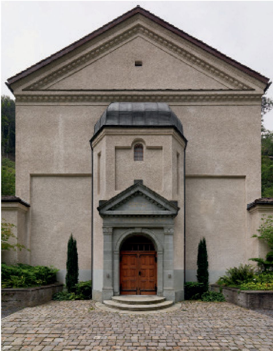
Krematorium, Eingangsfront, Aufnahme 2012 (Foto: Javier Miguel Verme, Chur).
