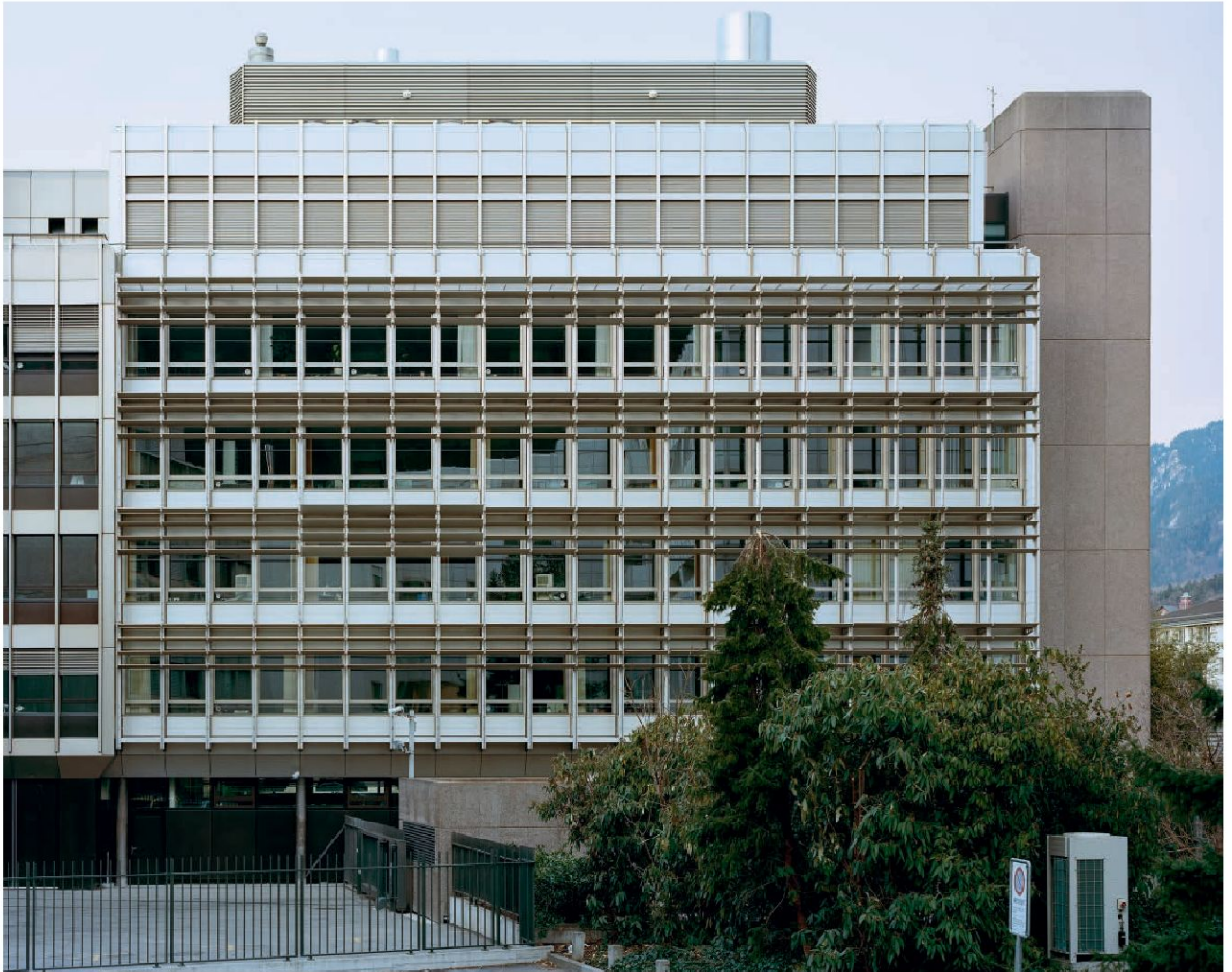
Verwaltungsgebäude der Graubündner Kantonalbank, Engadin-/Gäuggelistrasse, Chur, Hans Peter Menn, 1979–1981.
