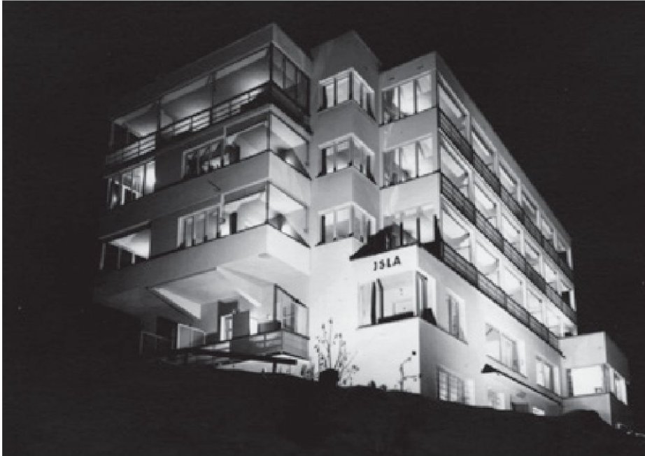
Oben: Hotel Isla, 1929 (Arch.: Jakob Licht). Unten: Die nach 2010 anstelle des Hotels Isla errichtete Ferienhaussiedlung.
