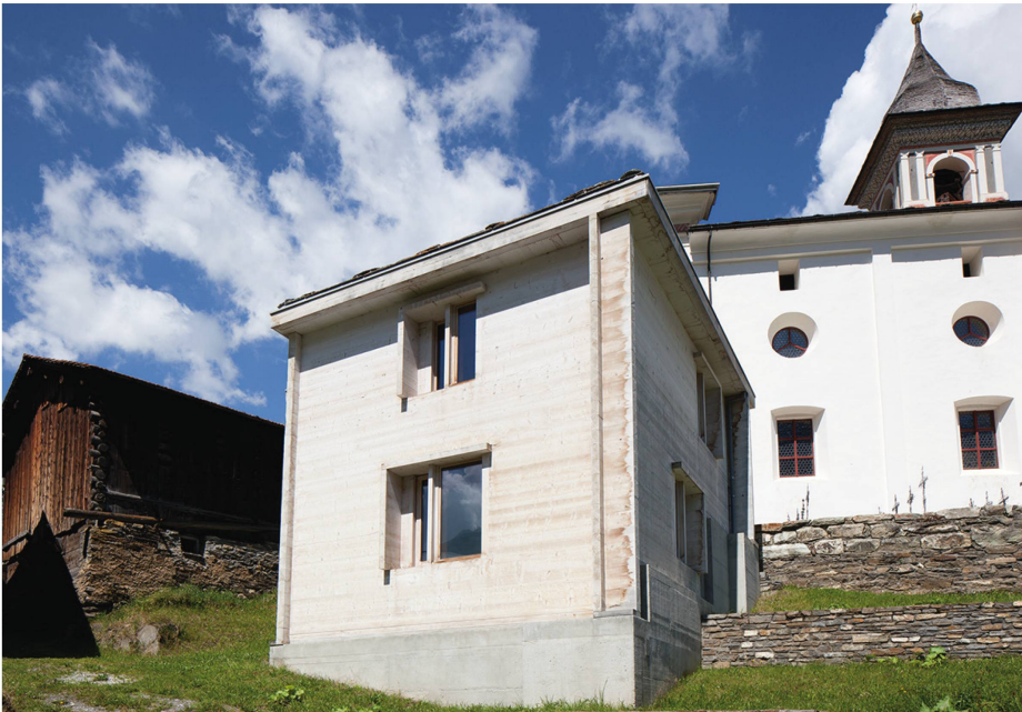
Das Totenhaus, die «Stiva da morts» (2003), steht sinnbildlich für das architektonische und kulturelle Schaffen von Gion A. Caminada in Vrin: In einer modernen Adaption des traditionellen Strickbaus, dessen Weiss sich an die Farbe der Kirche anlehnt, werden die Toten des Dorfes aufgebahrt (Foto: Schweizer Heimatschutz, 2011).
