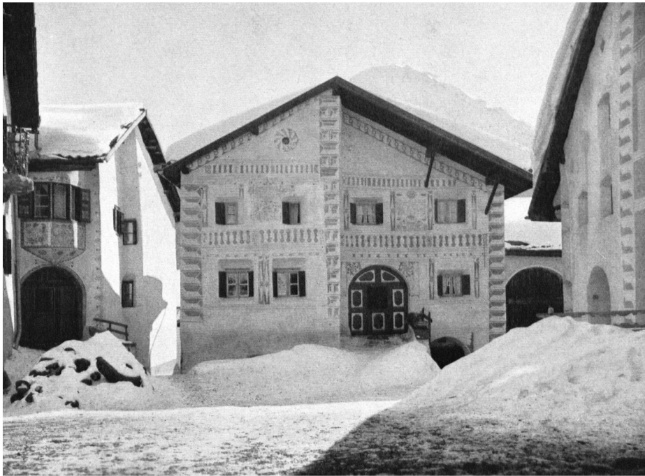
Die Häuser am Dorfplatz nach der Renovation. «Links: wiederhergestelltes Patrizierhaus, alter Erker, früher mit Schablonen übermalt, nun wieder mit echten handgemalten Ornamenten geschmückt. Mitte: die über-tünchten und übermörtelten Sgraffiti wurden freigelegt und erneuert.» (Heimatschutz 1/1941, S. 17).
