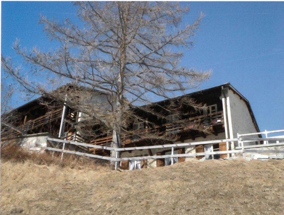
Laubenbalkon-Fassade der sorgfältig gegliederten Erweiterung des Logierhauses Piz Vizàn (Foto: Irma Nosedà 2010).
