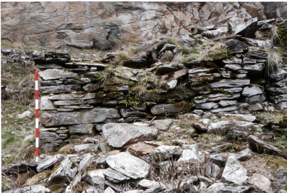
Scatta, Blick nach Norden. Südansicht der als Backofen identifizierten Struktur (Foto Y. Alther).
