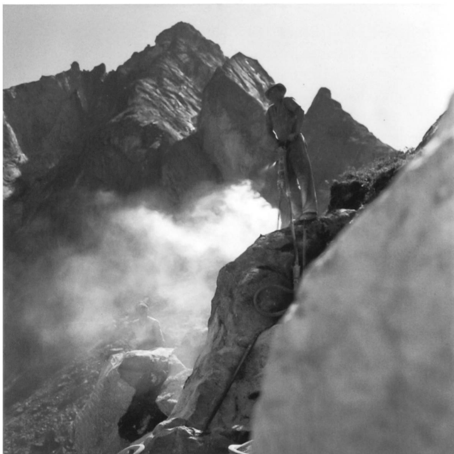
Ein Mineur bohrt ein Sprengloch, um eine Sprengleitung zu verlegen (Foto: Urs Beyeler, Bern).
