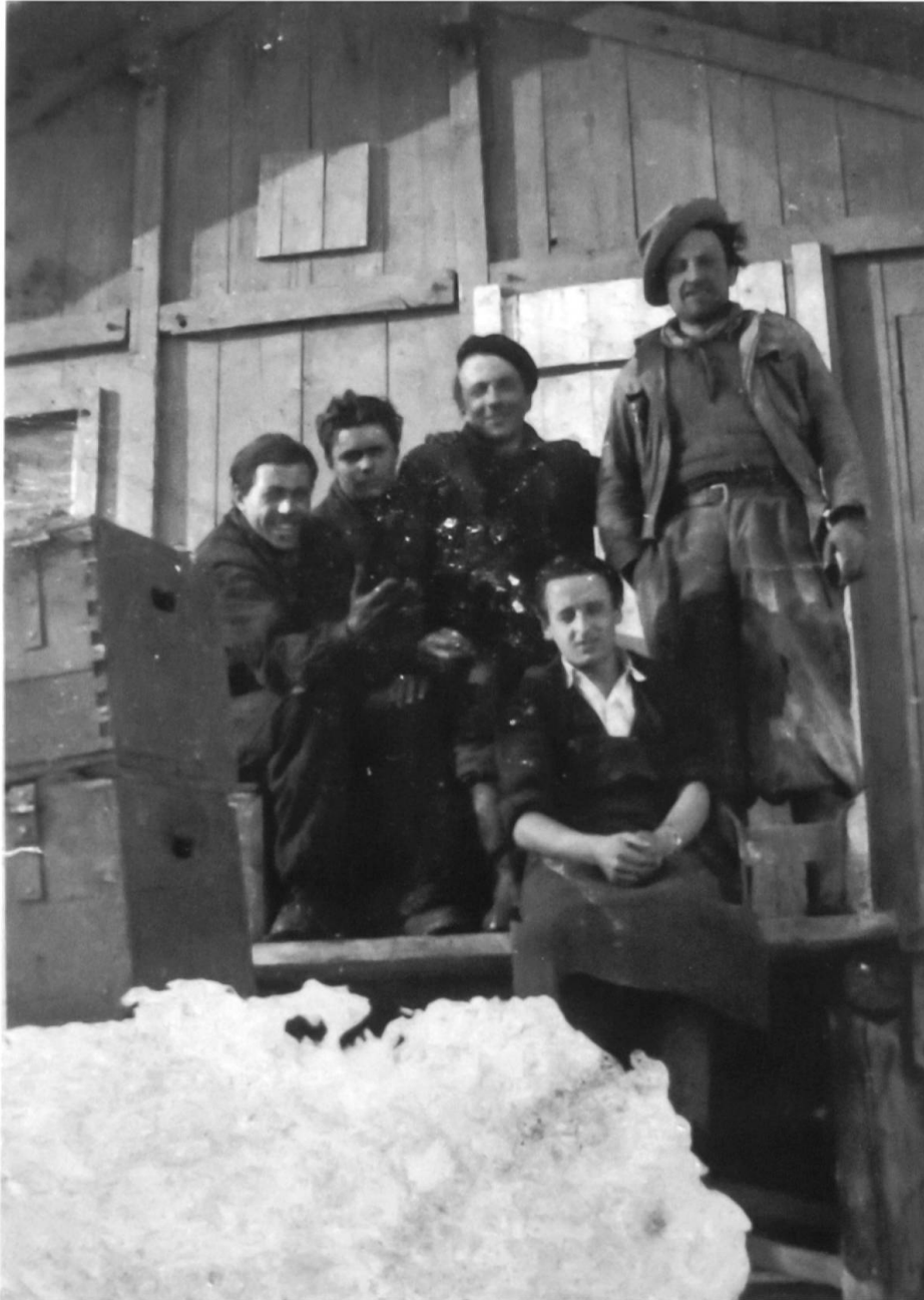
Arbeiter auf der Baustelle Murtaira (Bild: Calisto Zarucchi).
