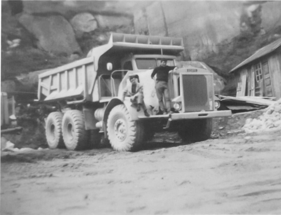
Muldenkipper aus den USA auf der Baustelle Albigna (Bild: Ugo Rossi).
