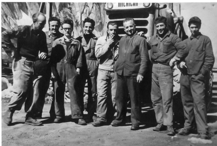
Arbeiter auf der Baustelle Albigna (Bild: Ugo Rossi).
