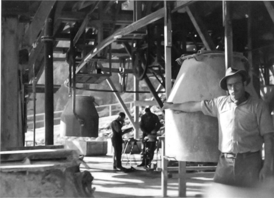
Bergstation der Zement-Seilbahn auf der Baustelle Albigna (Bild: Ugo Rossi).
