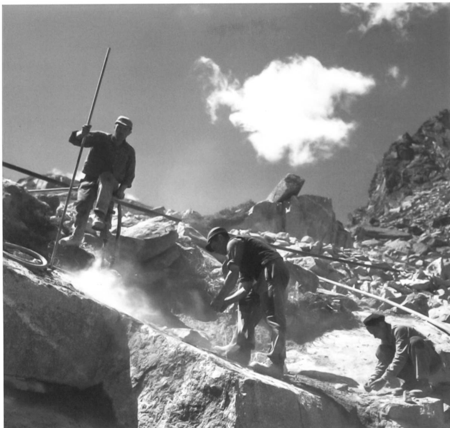
Mineure bohren Sprenglöcher und verlegen gleichzeitig Sprengleitungen (Foto: Urs Beyeler, Bern).
