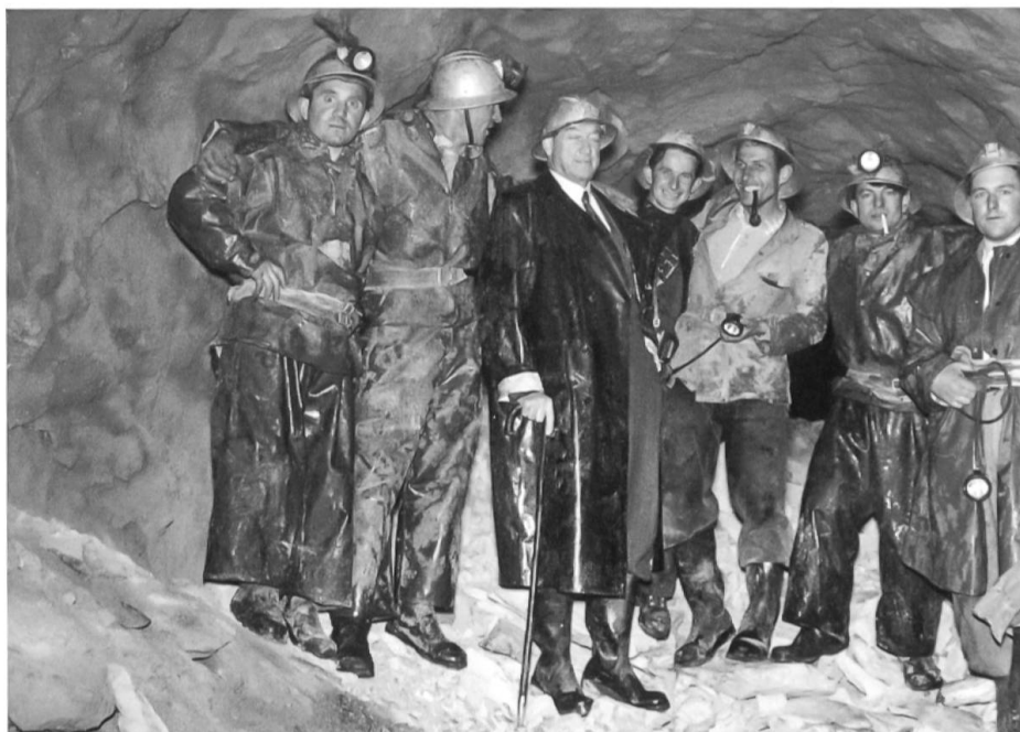
Vor dem Durchschlag des Freispiegelstollens im Herbst 1960. Fünfter von links: mein Mann Werner.
