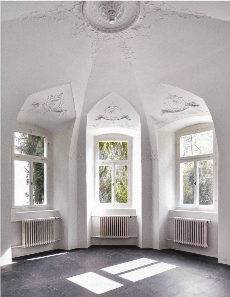
Untergeschoss, Ecksaal der Garten- und Stadtseite. Gewölberaum mit Stuckaturen.
