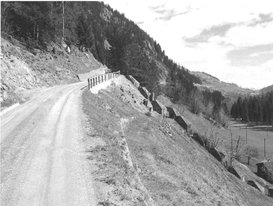
Wohl in der Annahme, dass den Panzern kein Gelände zu steil sei, wurde die BBB-Höckerreihe des GPH Russein (T 04520) hier weit in den Steilhang über Madernal hinaufgezogen (Foto: Thomas Bitterli-Waldvogel).
