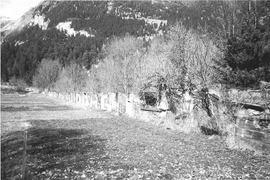
Quer über die Ebene von Las Seaz bei Trin erstreckt sich die Betonhöckerreihe des GPH ( T 04070). Ansicht der Freundseite; die Feindseite ist heute mit Büschen und Bäumen überwachsen (Foto: ADAB-Inventar 1998).
