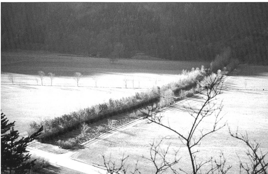
Blick vom Artilleriewerk Anstein auf das Geländepanzerhindernis Anstein (T 03326). In der vorderen Reihe das 1939 errichtete Infanteriehindernis aus einbetonierten Schienen. Dahinter, vom Gebüsch überwuchert, die Reihe der Betonhöcker von 1941 (Foto: ADAB-Inventar 1999).
