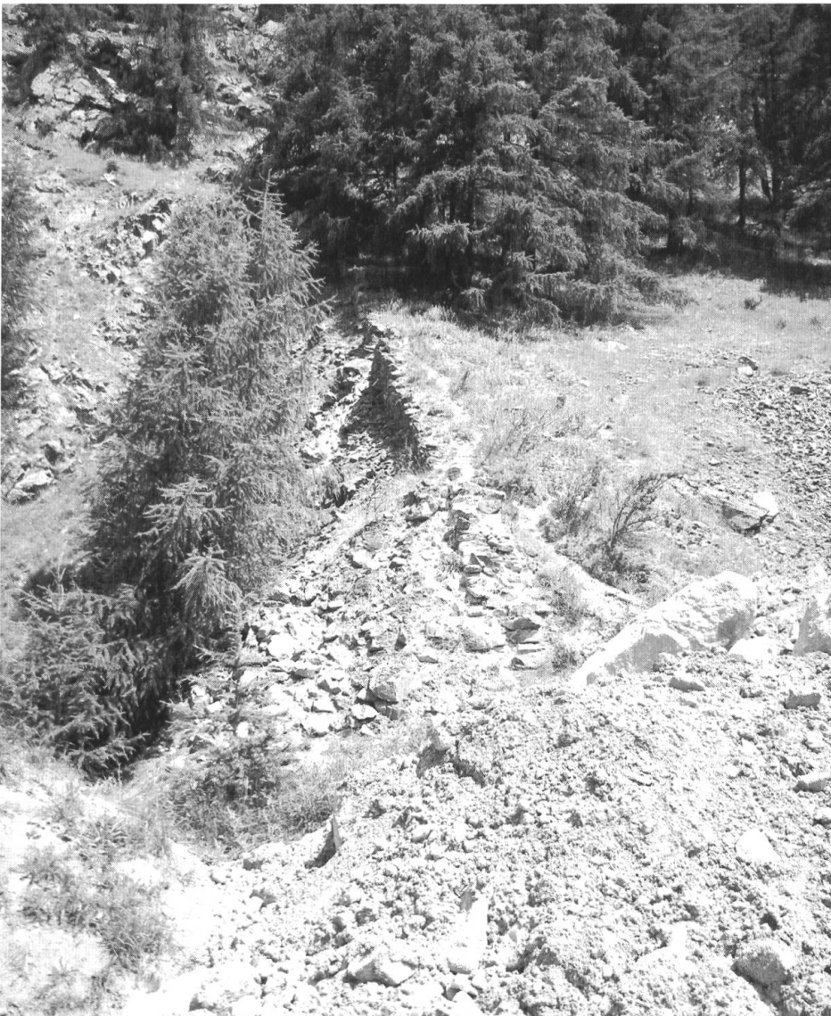
Reste der Sperrmauer Serra bei Zerneß vom Ende des 15. Jahrhunderts (Foto: Thomas Bitterli-Waldvogel).
