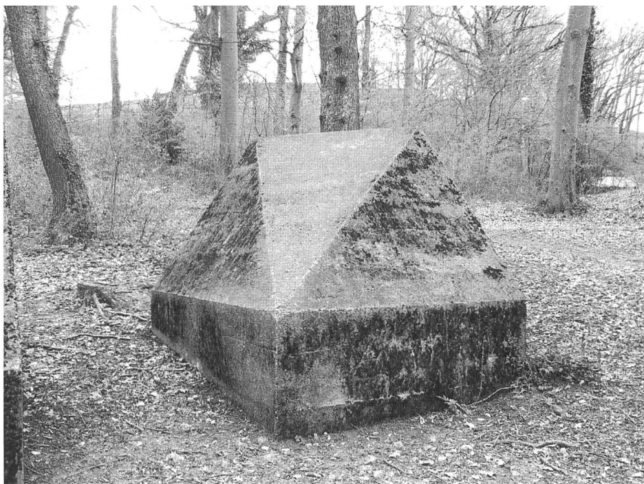
Ansicht der Feindseite eines BBB-Blocks (Foto: Thomas Bitterli-Waldvogel).
