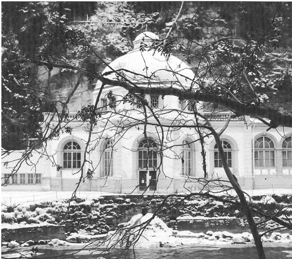
Kultort des Wassers: das Brunnenhaus (Foto: Denkmalpflege Graubünden).
