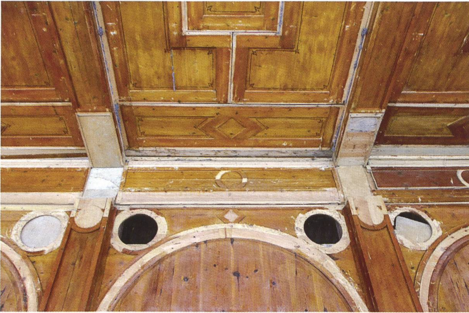
Profile abgeschlagen: das durch die Purifizierungs-Altion von 1963 versehrte Täfer der Wandelhalle (Foto: Denkmalpflege Graubünden).
