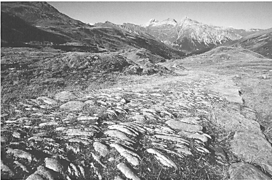
ViaSpluga: Im Vordergrund der Saumweg, über den die ViaSpluga verläuft und im Hintergrund die um 1820 gebaute Kommerzialstrasse (Foto: ViaStoria/Heinz Dieter Finck).
