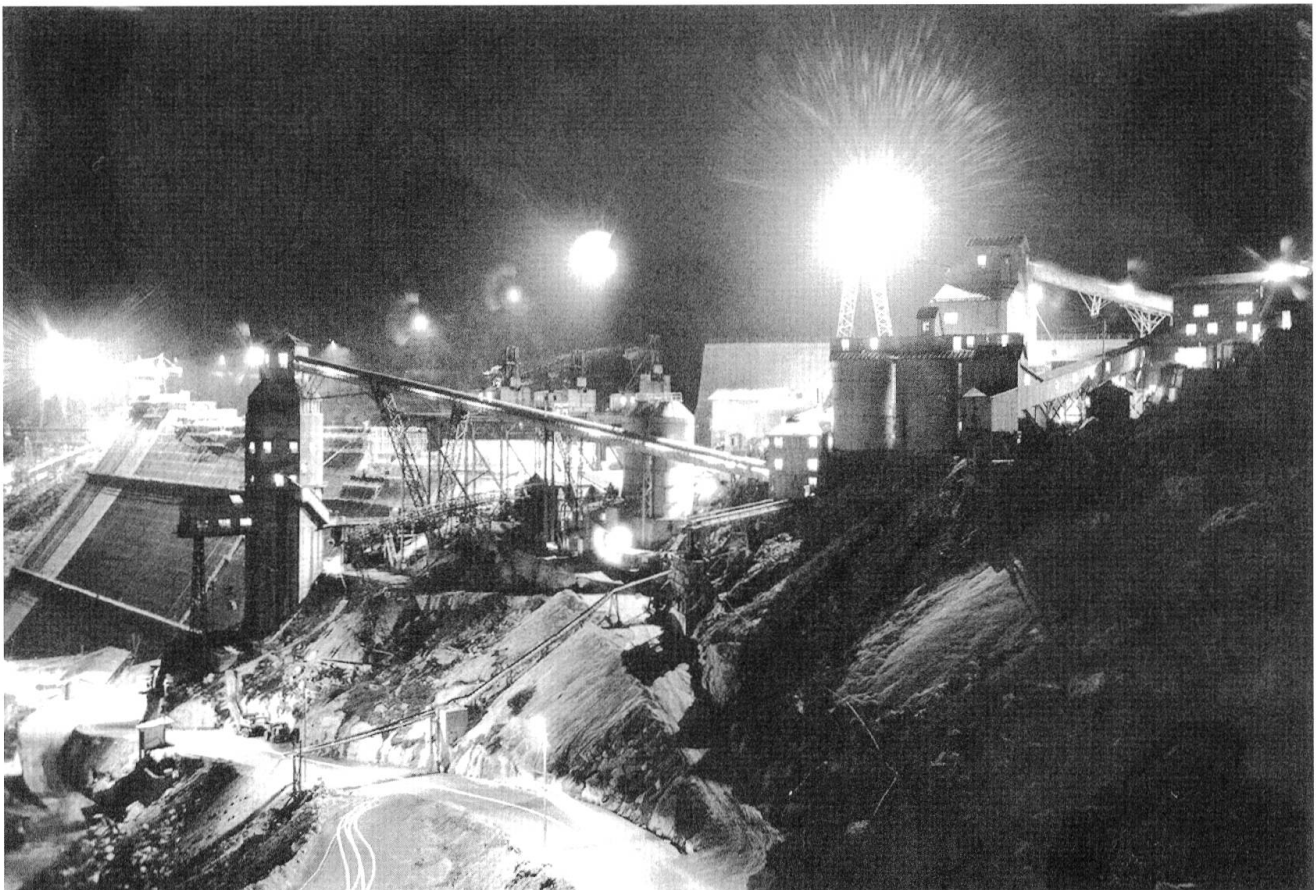
Abb. 45: Baustelle Albigna bei Nacht.
