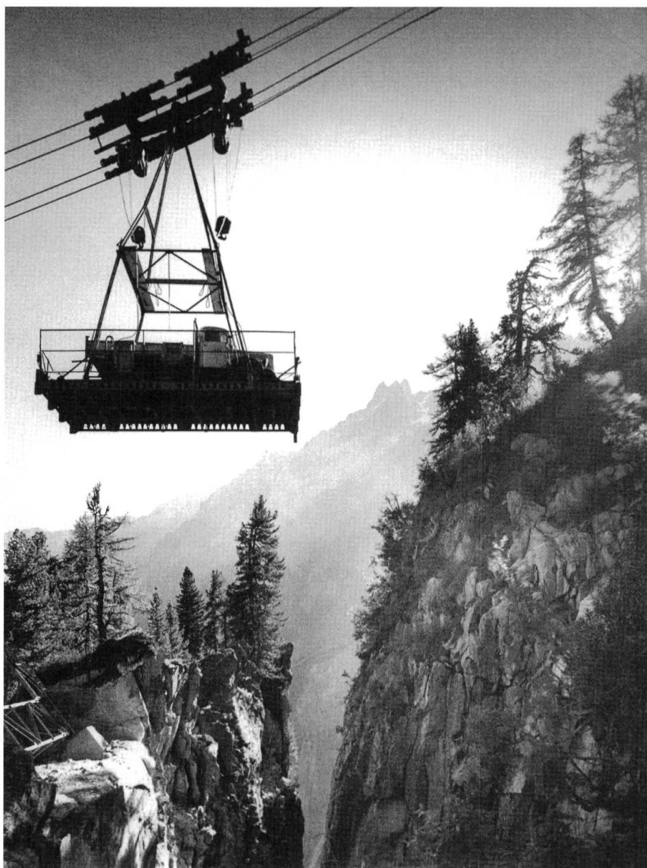
Abb. 31: Schwerseilbahn, die bis zu 16 Tonnen von Crot nach Sasc Prümaveira brachte: Lastwagen auf der Transportplattform über der Schlucht bei Sasc Prümaveira.
