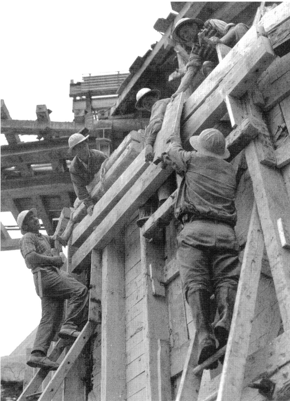
Abb. 48: Arbeiter beim Bau der Staumauer auf Albigna.
