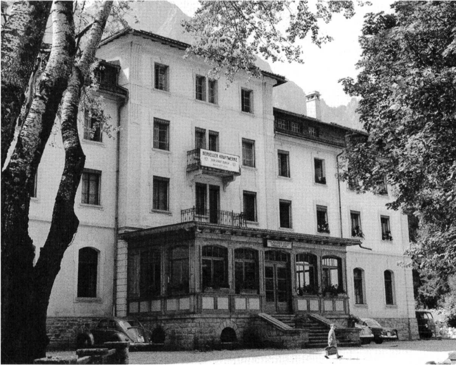
Abb. 46: Hotel Helvetia, das 1955 von Zürich gekauft wurde. Hier waren die Büros der örtlichen Bauleitung sowie Wohnungen für Ingenieure und ihre Familien untergebracht.
