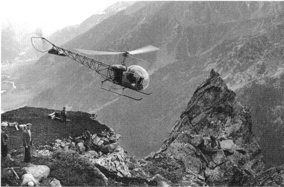
Abb. 36: Für die Einrichtung der Baustelle Murtaira wurden auch Helikopter eingesetzt.
