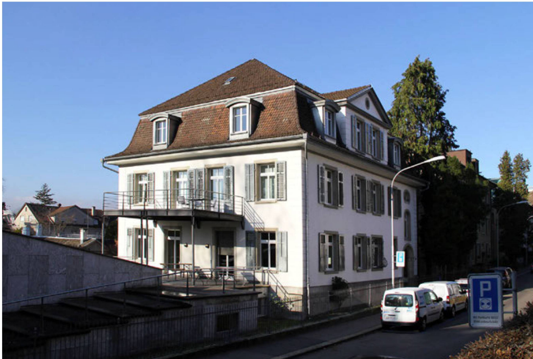
Abb. 11: Nordistik Zürich, Pestalozzistrasse 50 (Foto: Monika Gradalska)
