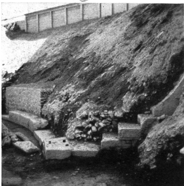
Fig. 11 - Piédrait sud de l'entrée occidentale,
