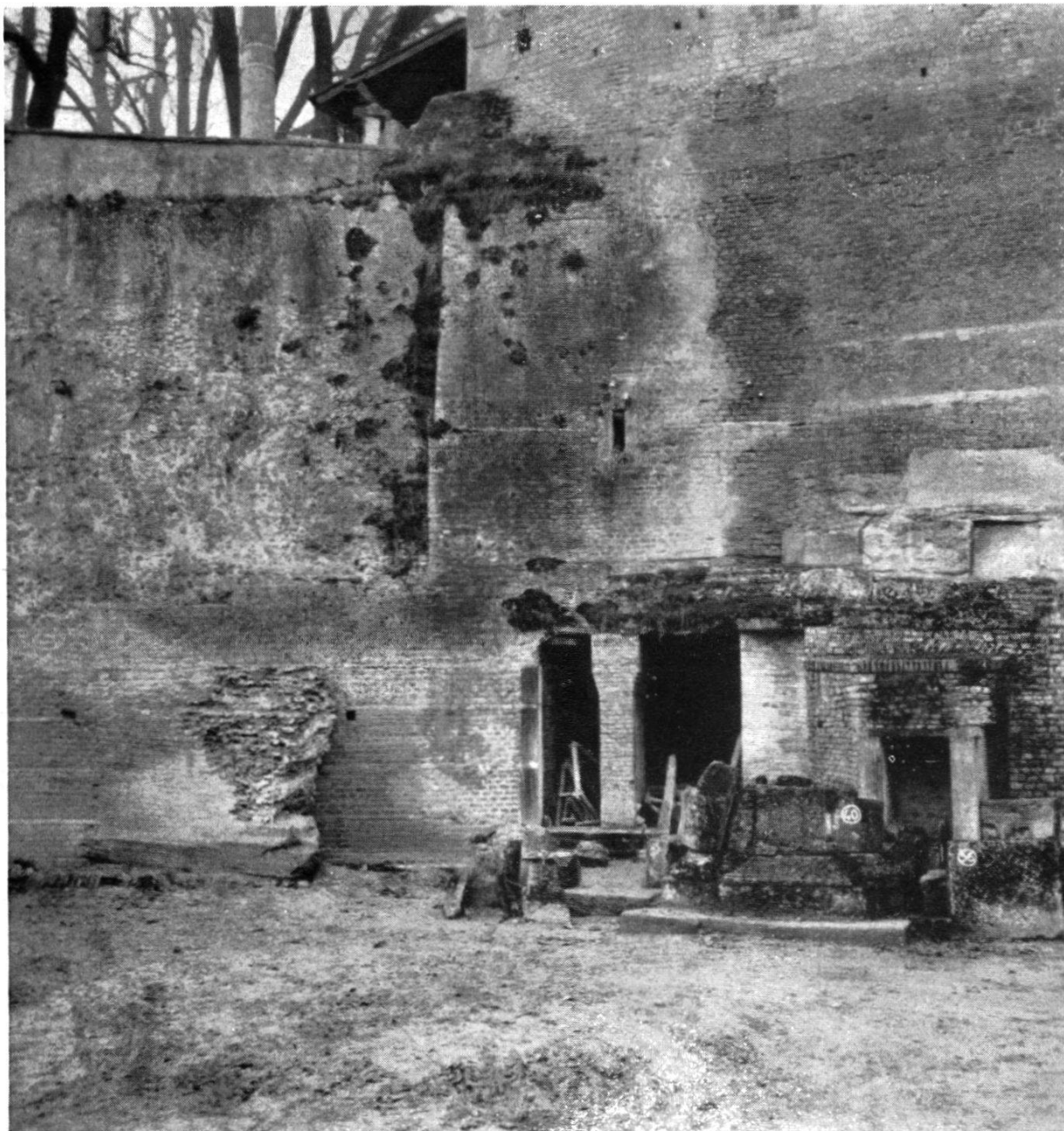
Aspect de l'entrée Sud avant la restauration.
