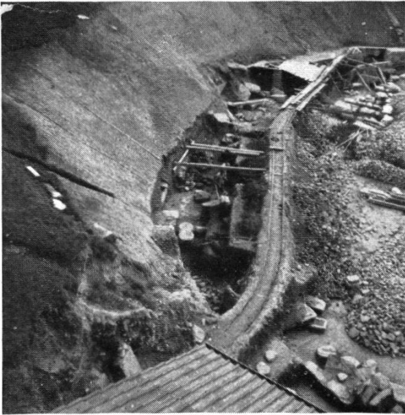
Fig. 13 - Régalinge des talus de la Cavea, au Sud-Est.
