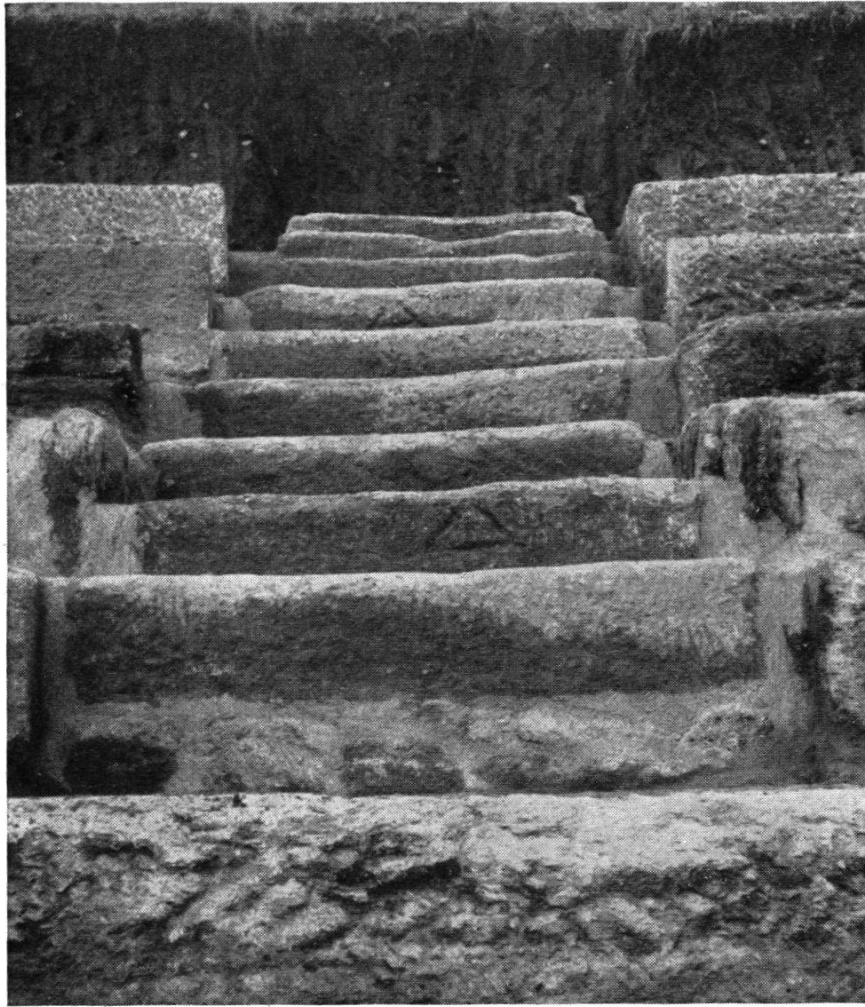
Fig. 38 - Secteur Nord. La rampe d'escaliers « in situ ».
