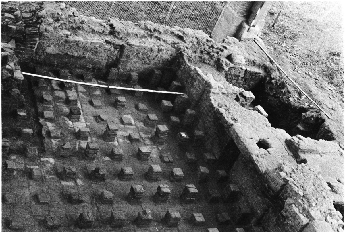
Abb. 2. Tepidarium S-Ecke mit Zwischenwand zum Caldarium (rechts) und Durchlass für Warmluft.
