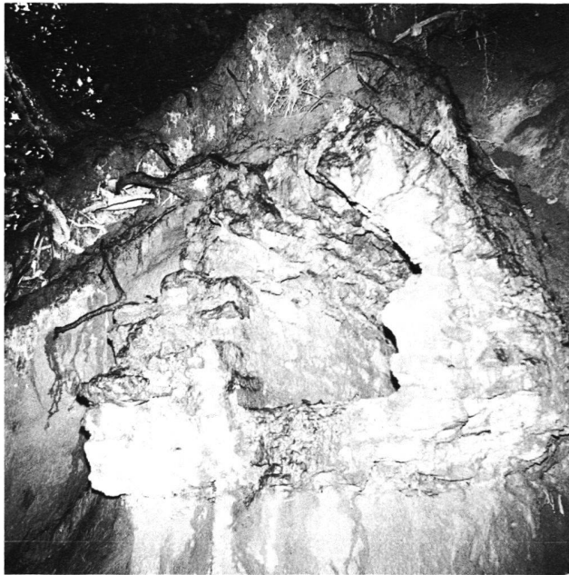
Fig. 3. Aqueduc de Coppet, 3 e tronçon.
