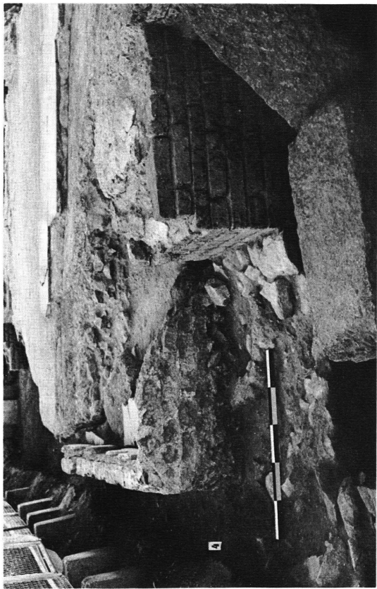
Abb. 1. Frigidarium N-Wand aussen mit (abgebrochener) Ummauerung der Mittelapsis Periode II und stehengebliebenem Wandverputz aus Ziegelmörtel (über Masstab 1 m).
