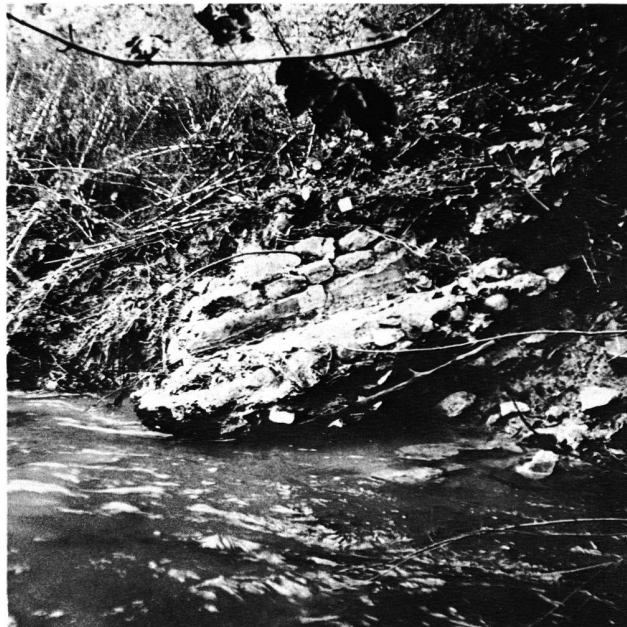
Fig. 2. Aqueduc de Bonne-Fontaine, reste du point 3.
