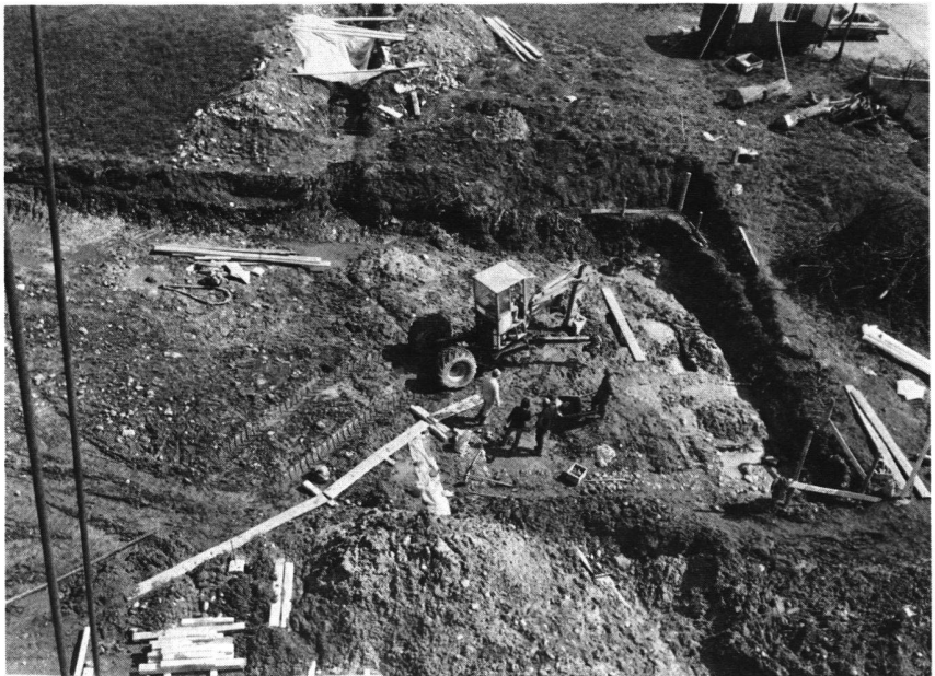
Photo 2 Début de la fouille, en symbiose avec la pelle mécanique...
