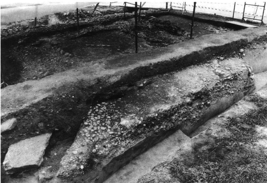
Fig. 25. Avenches / Prochimie. Zone 3. Coupe transversale de la route romaine menant au port de rive antique.
