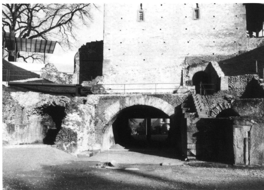
Fig. 18. Avenches, Amphithéâtre. Les accès orientaux vus de l'arène. En haut à gauche, on aperçoit l'extrémité des abris protégeant le secteur non restauré du mur périphérique à alvéoles. Escaliers, passerelle et barrières jalonnent un nouveau cheminement de visite.
