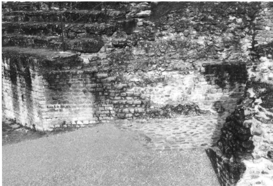
Fig. 17. Avenches, Amphithéâtre. Débouché actuel du passage nord dans l'arène. Les vestiges du massif supportant autrefois l'escalier menant à la base des gradins ont été restaurés pour situer l'emplacement de celui-ci.
