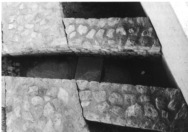
Fig. 19. Avenches / Insula 29, thermes de «Perruet». L'aqueduc au passage du mur nord du frigidarium, vu de l'est. A droite, les piédroits rebâti et le mur en béton de l'enclos. Le radier d'opus spicatum n'est ici pas encore restauré.
