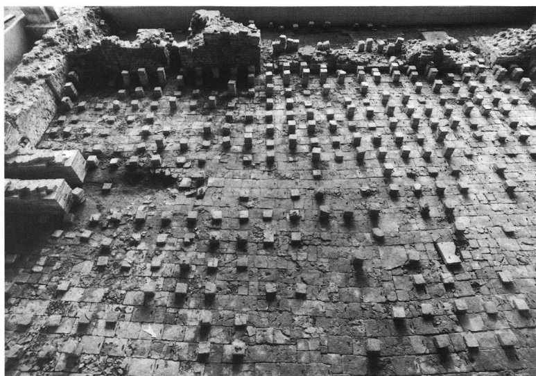
Fig. 18. Avenches / Insula 29, thermes de «Perruet». L' area du tepidarium après nettoyage. Vue plongeante de l'est.
