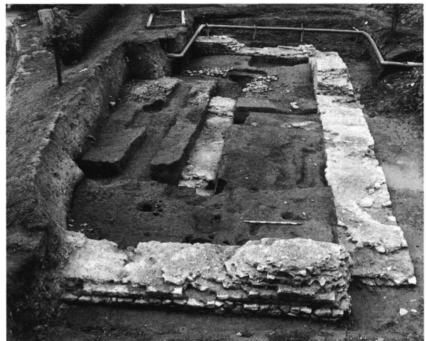
Fig. 5. Avenches / Temple de Derrière la Tour. Les fondations de la partie arrière du temple et les vestiges des aménagements culturels d'époque augustéenne. Vue du nord.
