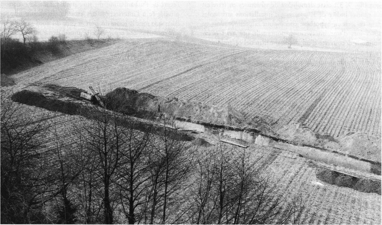
Fig. 10 Avenches / Creux aux Patrons. Portion de la tranchée ouverte en contrebas de la Tornallaz. Vue de l'est.
