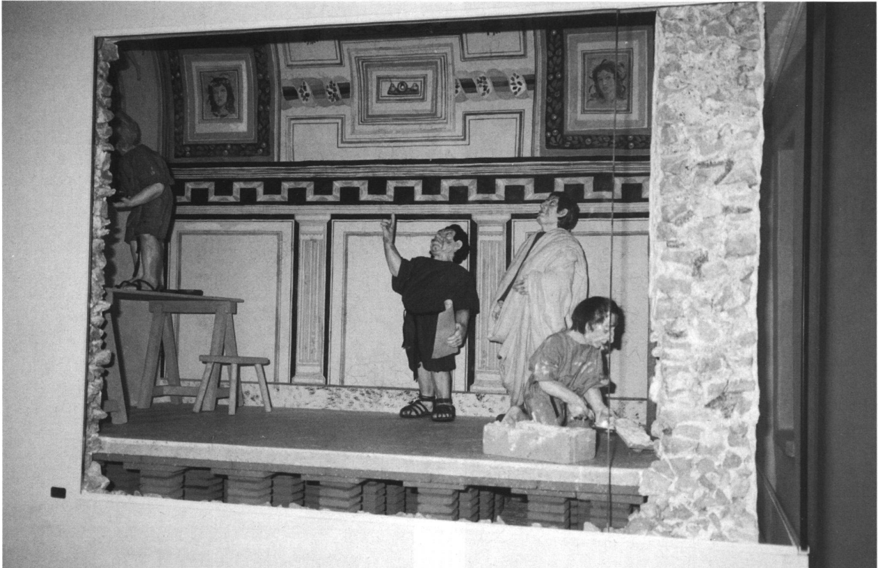
Fig. 3. Maquette de la « Chambre blanche ». Elle illustre l'exécution d'une peinture murale à fresque par un atelier. L'ouvrier taloche les premières couches de mortier, le peintre applique les couleurs, le maître d'ouvrage discute avec le propriétaire. La peinture est appliquée sur la dernière et plus fine couche de mortier encore humide. Réalisation et photo A. Glauser.
