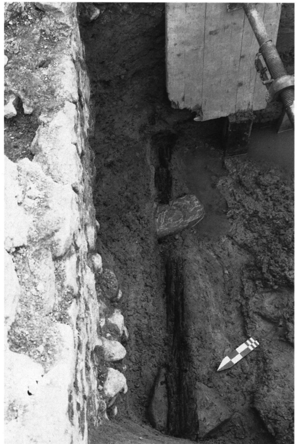
Fig. 24. Insula 20, bâtiment ouest, juxtaposition des murs de la façade occidentale du quartier: sablière de la phase augustéenne tardive et soubassement maçonné des constructions postérieures.
