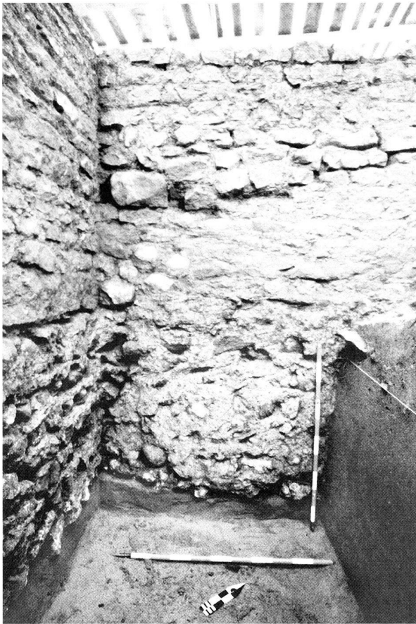
Fig. 50. Insula 18, 1986. Bâtiment riverain nord-est. Les impressionnantes fondations du local L 40*, implantées à une profondeur de 2,60 m par rapport au sol de la pièce (fig. 36). Etat 3 (70-150). Vue depuis le sud.
