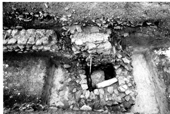
Fig. 38. Insula 12, 1986. Domus Est. Le puits-citerne St 209 et la canalisation St 208 de la cour nord-est L 58 en cours de fouille (fig. 36). Etat 4 (150-III e s. ap. J.-C.). Vue depuis l'est.
