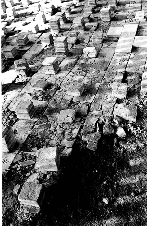
Fig. 2. Détail du sol du tepidarium. Etat avant restauration. Photo MRA.
