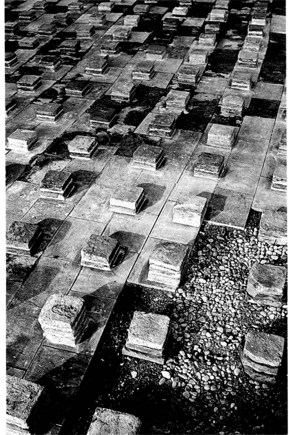
Fig. 3. Même détail après restauration. Les lacunes du dallage déjà présentes lors du dégagement de 1954 ont été comblées par du gravier. Photo MRA.
