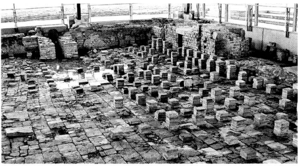
Fig. 4. Le sol du tepidarium. Etat au commencement des travaux. Au fond, une flaque d'eau due à la remontée périodique de la nappe phréatique. Avec les gels hivernaux, c'est l'un des facteurs principaux de la dégradation du monument. Photo MRA.
