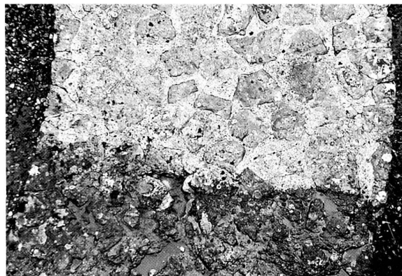
Fig. 11. Pour permettre au mortier de restauration de s'accrocher à l'ancien, il a fallu procéder à un nettoyage profond par hydrosablage. La photo illustre l'effet de ce type de nettoyage sur une chape. Photo MRA.
