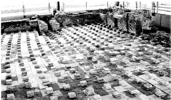
Fig. 5. Le même secteur après restauration. Pour près des deux tiers, le dallage de terre cuite original a été remplacé par des dalles de ciment teinté. Photo MRA.
