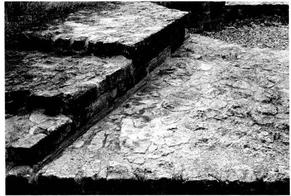
Fig. 10. La même chape après restauration. Une saignée a été pratiquée au pied du mur de gauche pour faciliter l'écoulement des eaux pluviales. Photo MRA.
