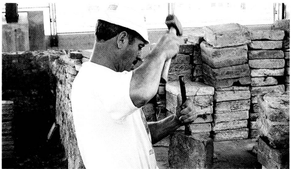
Fig. 7. Le mortier dur des années 1950 est enlevé avant remontage des pilettes, qui seront scellées par un mortier de chaux légèrement teinté. Photo MRA.
