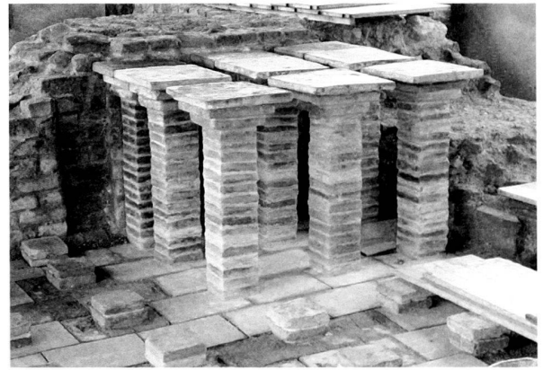
Fig. 4. Les Thermes de Pernet, tepidarium, angle nord-ouest. Première étape de reconstitution d'un secteur didactique présentant le système de chauffage romain par hypocauste. Photo MRA.
