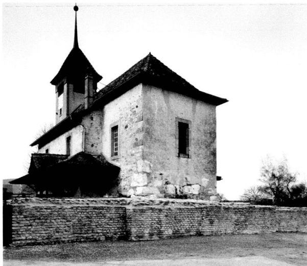
Abb. 18. Ursins (FR). Oben: Grundriss des Tempels. Unten: Ansicht der Kirche nach der Restaurierung von 2002, gegen Südwesten. Die Terrassierungsmauer vorn aus römischer Zeit. Das Chor und der kleine Glockenturm wurden an die antike Tempel-cella angebaut, in der ein Kirchensaal eingerichtet wurde. Grundriss: Jean-Blaise GARDIOL, Recherches au fanum d'Ursins VD , in: ASSPA 72, 1989, S. 290-294, fig. 1.
