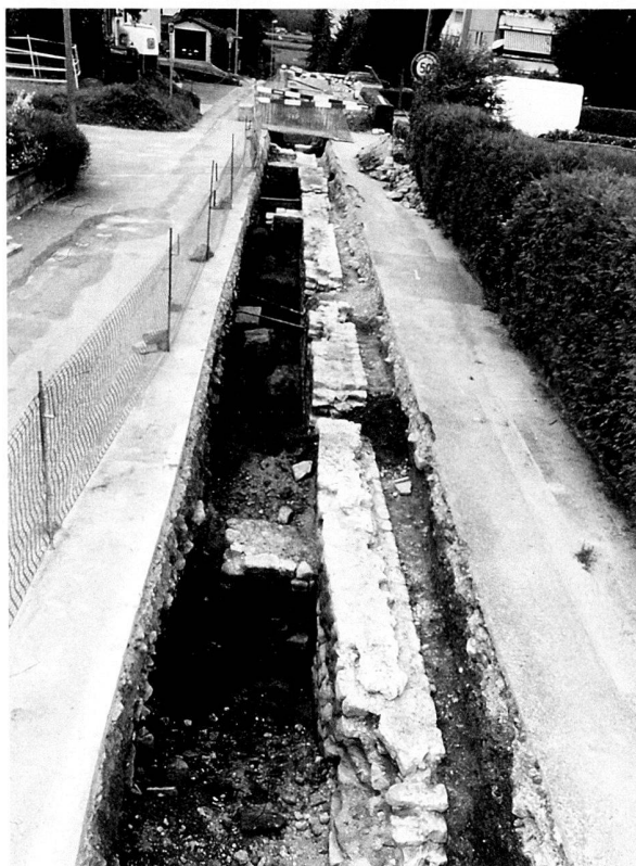
Fig. 21. Avenches/Insula 19. Les locaux de service de l'aile orientale de l'édifice thermal partiellement mis au jour à la route du Moulin. Vue du sud. Epoque flavienne.
