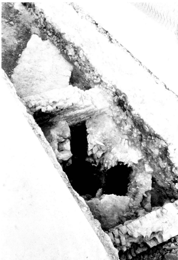
Fig. 24. Avenches/Insula 19. Détail de deux collecteurs voûtés courant sous des murs mis au jour dans la partie centrale de la tranchée ouverte en bordure de la route de Berne, et appartenant à la partie sud de l'édifice. Vue du sud-est.
