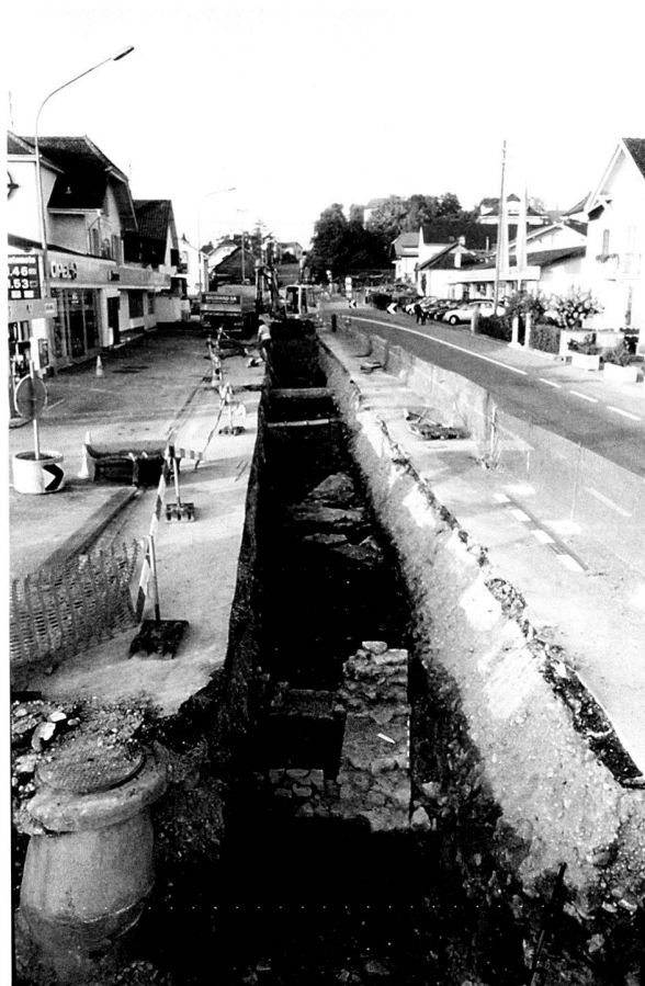
Fig. 23. Avenches/Insula 19. Vue générale de la partie est de la tranchée ouverte en bordure de la route de Berne. Au premier plan, les murs d'un petit local appartenant à la partie sud des thermes. Au second plan, le point de rencontre entre deux systèmes d'évacuation d'eau d'époques différentes.
