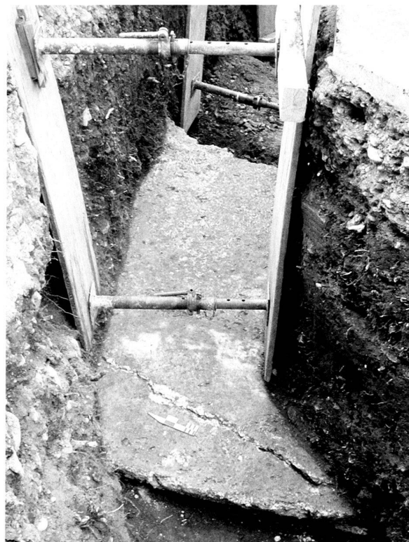
Fig. 11. Avenches/Avenue Jomini 9 – Maison d'Enfants d'Avenches. La portion dégagée du sol de terrazzo de la galerie périphérique du nouvel édifice circulaire. Au premier plan, la bordure incurvée de ce sol demeure intacte en dépit de la récupération du mur externe de la galerie. Vue de l'ouest. I re moitié du II e s.- III e s. ap. J.-C.
