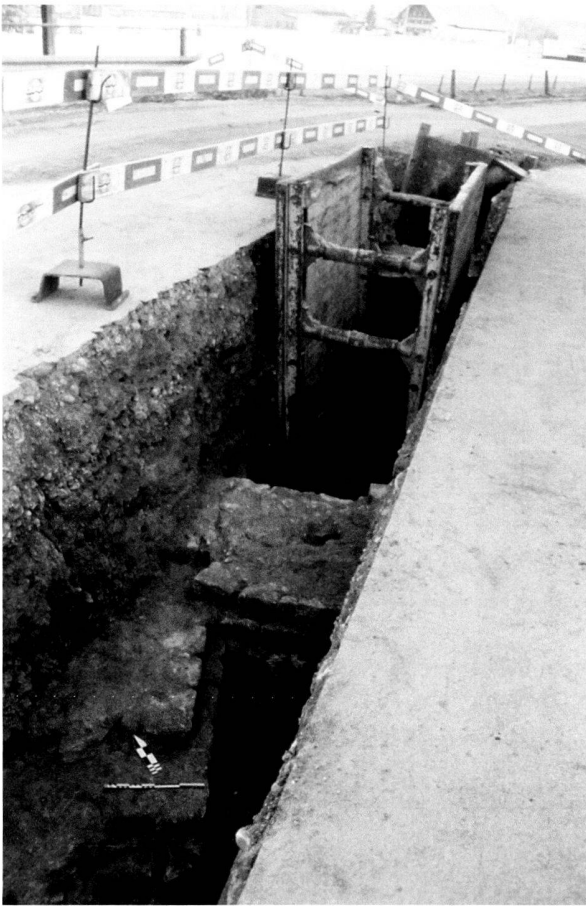
Fig. 27. Avenches/Route de Sous-Ville. Détail de la tour n° 26. Vue du sud-ouest.
