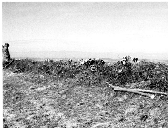
Fig. 3. Le Mur d'enceinte après débroussaillage, le long de la route de Donatyre. Photo MRA.
