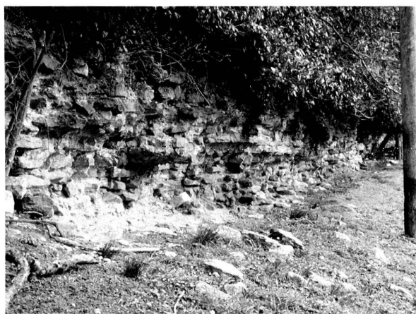
Fig. 4. Le Mur d'enceinte Au Lavoir. Photo MRA.
