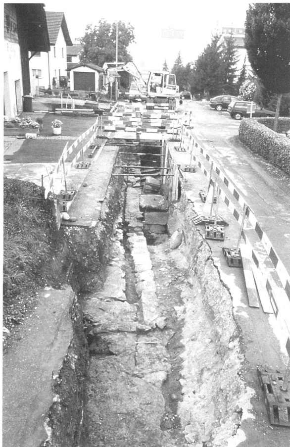
Fig. 12. Avenches/Insulae 13-14, voirie. Vue du mur accolé au piedroit oriental de l'égout collecteur ainsi que des deux piles découvertes à l'angle sud-est de l' insula 14.
