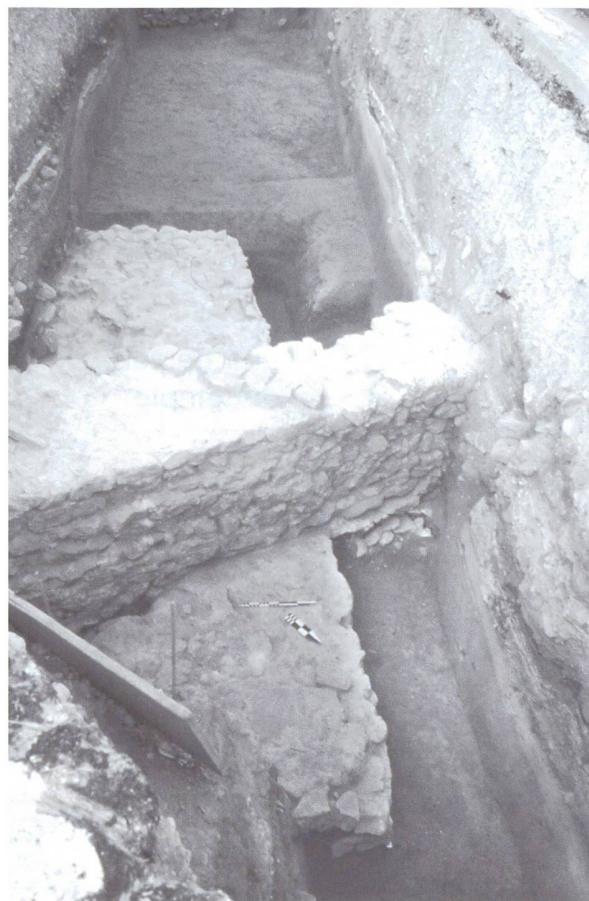
Fig. 13. Aire sacrée de la Grange des Dîmes. Le mur de péribole oriental du sanctuaire (M2) chevauche le soubassement maçonné (cf. fig. 3, 2 et fig. 12). Vue du nord-est.
