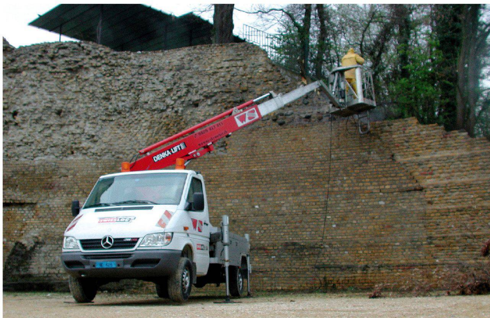
Fig. 4 (ci-contre) Amphithéâtre. Nettoyage et consolidation provisoire du mur semi-circulaire du Rafour.
