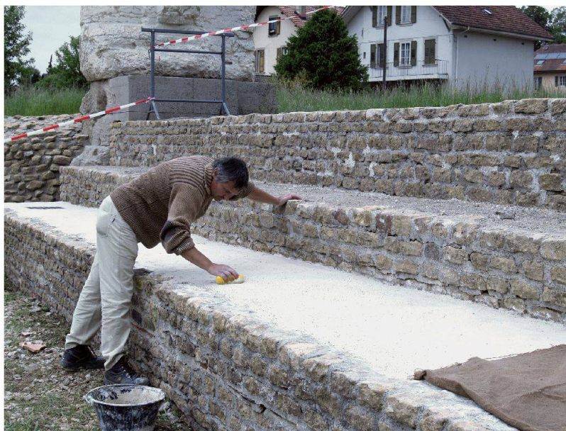
Fig. 8 Sanctuaire du Cigognier. Nouvelle chape du portique nord-est.
