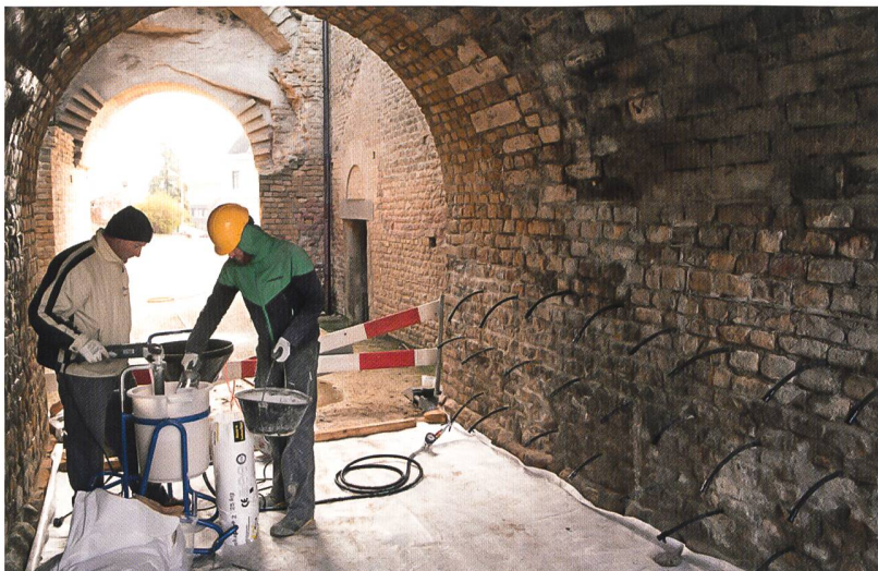
Abb. 22 (unten) Amphitheater, nördlicher Nebengang beim Ostzugang. Jacques Röthlisberger und Anjo Weichbrodt bei der Sicherung der Mauerzüge mittels Kalkmörtelinjektionen.
