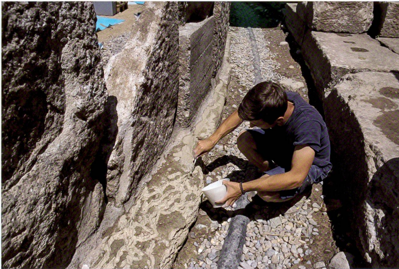
Abb. 26 (links) Amphitheater, Ostabschnitt des Arenaumgangs. Feinrestaurierung am Fundament der Orthostatenwand; Konservator Lionel Berger beim Verfugen von Rissen und Fehlstellen mit der eigens für diesen Zweck entwickelten Mörtelmischung.
