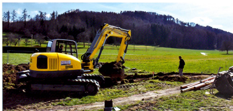
Fig. 51 2017.05. Donatyre, Chemin des Hôteaux. Vue des décapages mécaniques. À l'arrière-plan, on distingue le Bois de Châtel.
