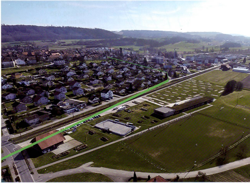
Fig. 24 2017.03. Zone sportive. Vue aérienne de la campagne de sondages effectuée en mars 2017. En vert le tracé restitué du mur d'enceinte.
