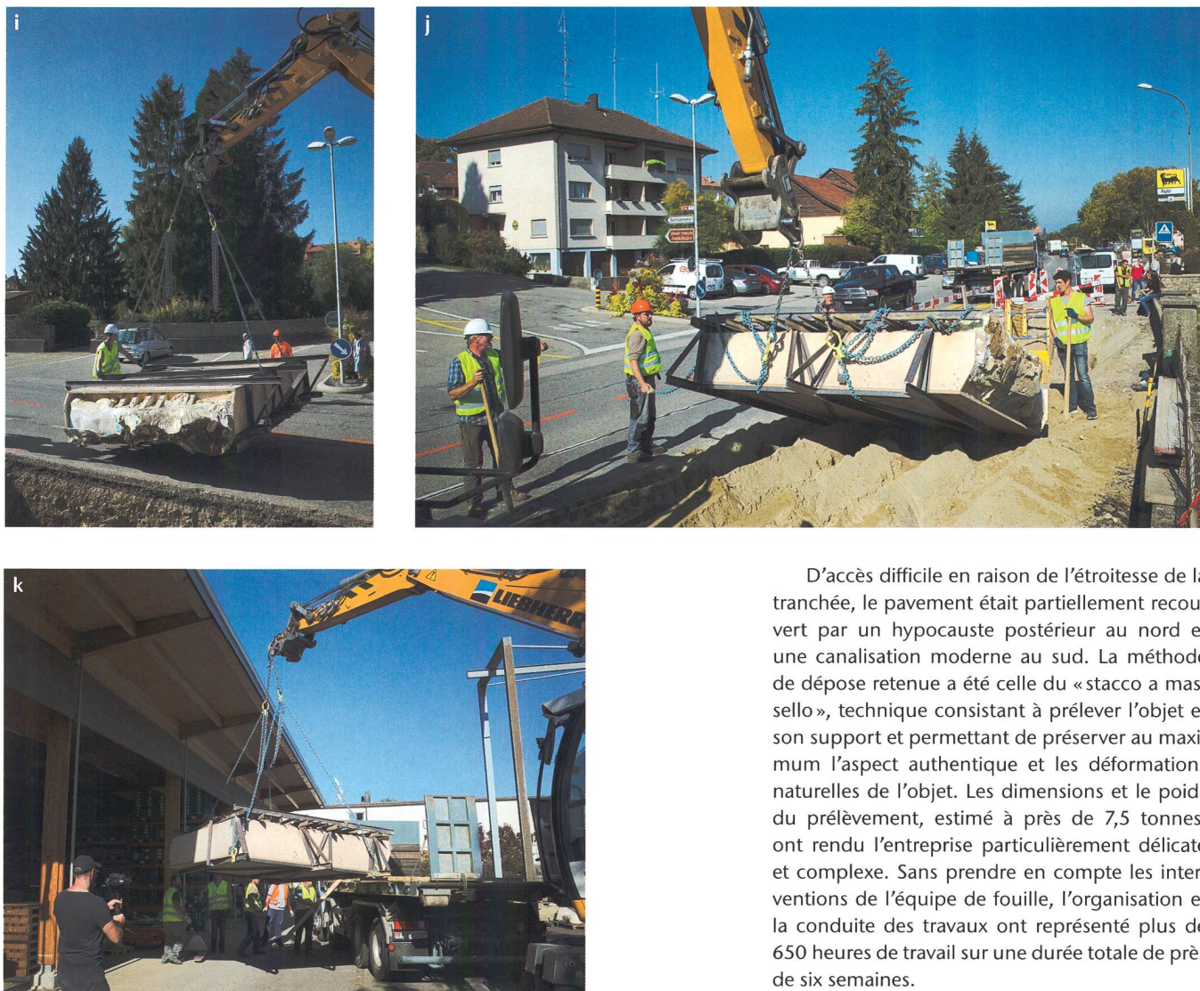
Fig. 3 (suite) Les différentes étapes du prélèvement de la mosaïque.
