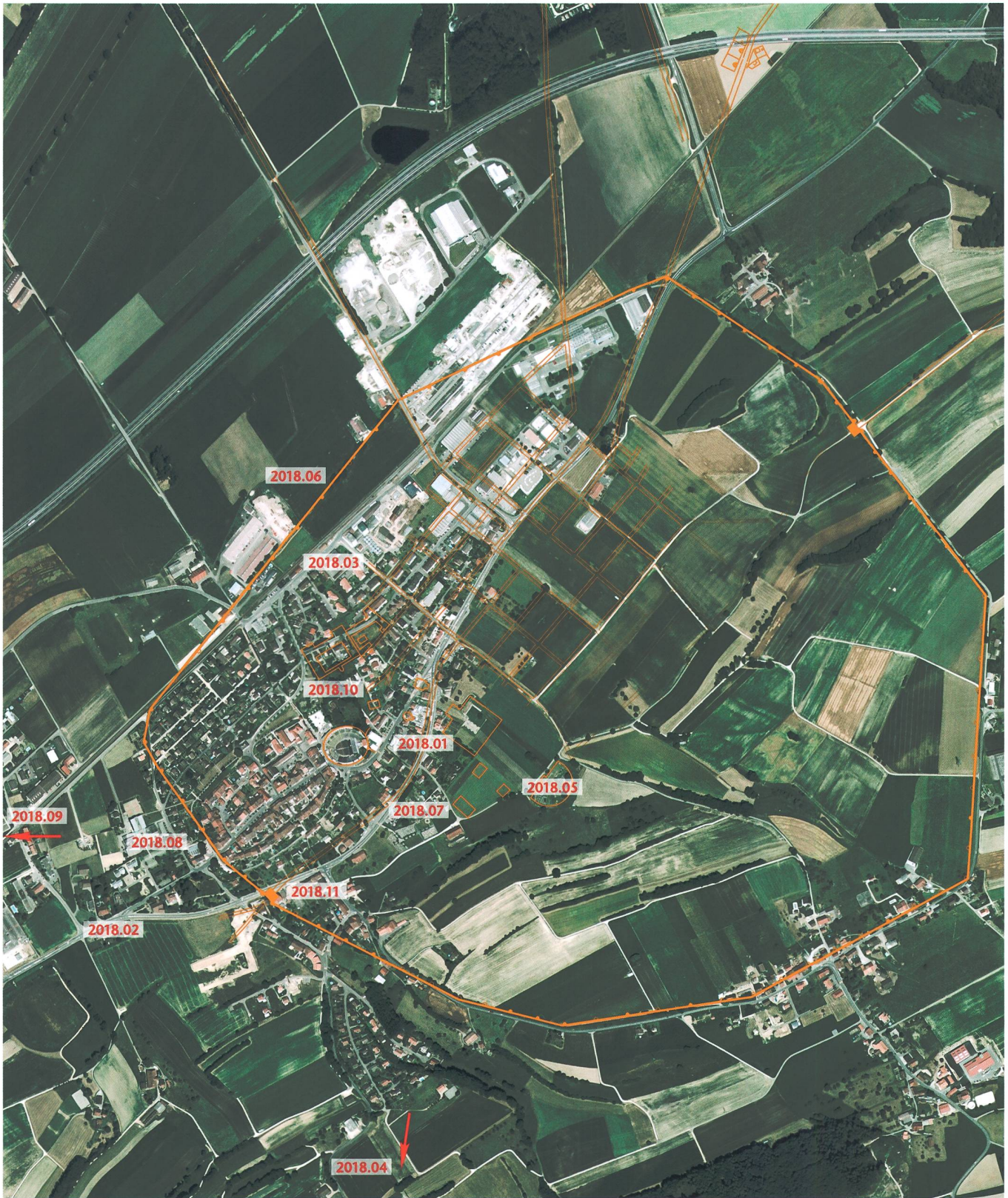
Fig. 7 Situation des interventions de 2018.
