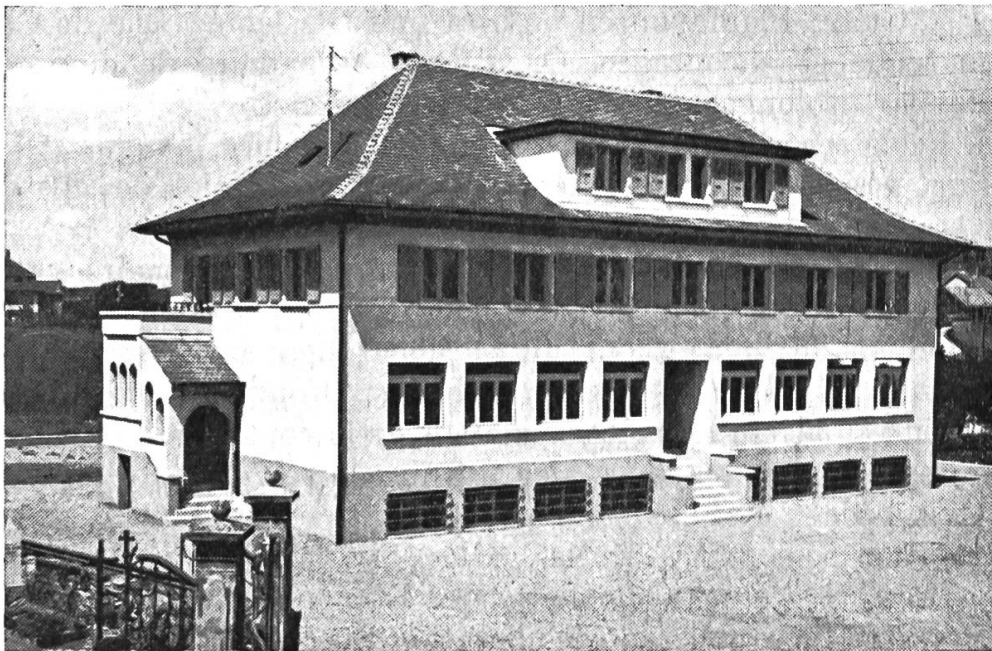
UNE ÉCOLE DE CAMPAGNE CONSTRUITE PENDANT LA GUERRE (SALES, GRUYÈRE)
