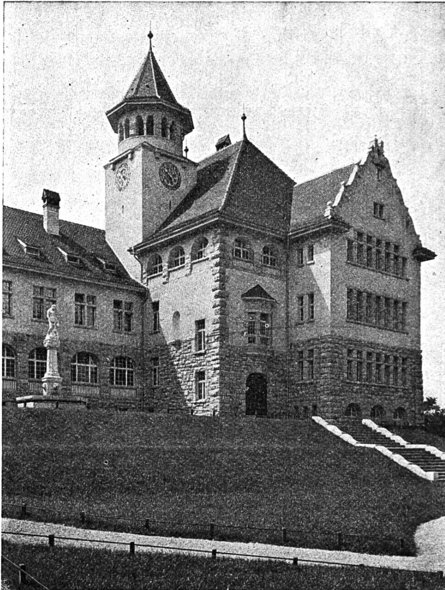
Stapferschulhaus, westlicher Flügel von Nordost (Schweiz. Bauzeitung).
