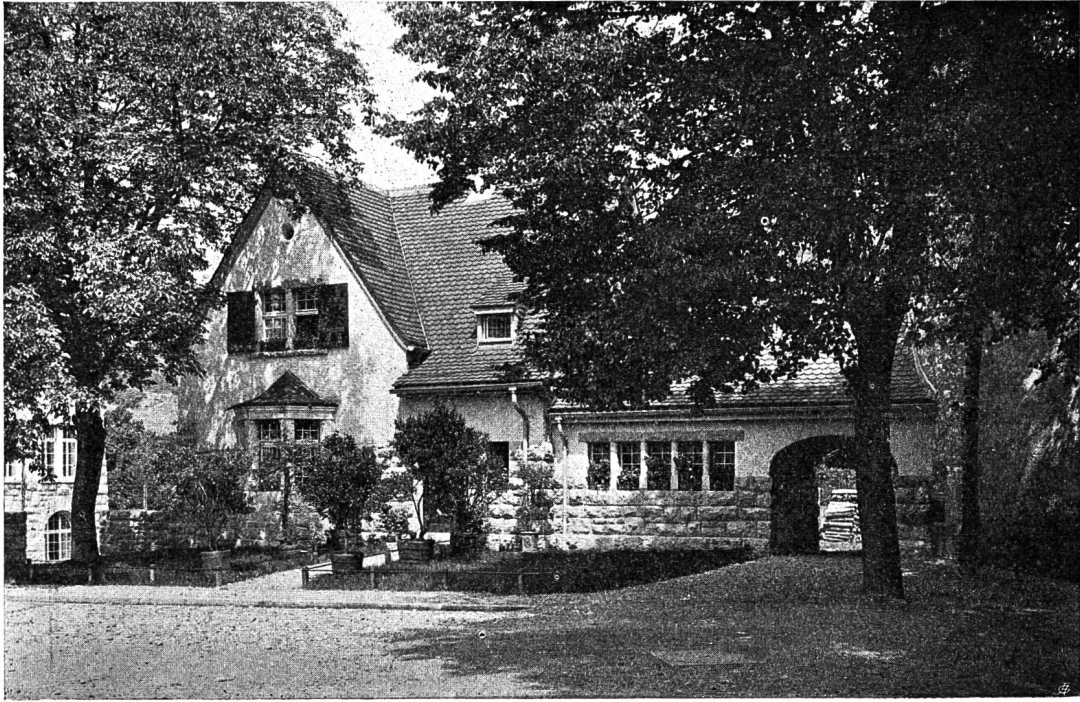
Abwarthäuschen von Südosten (Schweiz. Bauzeitung).
