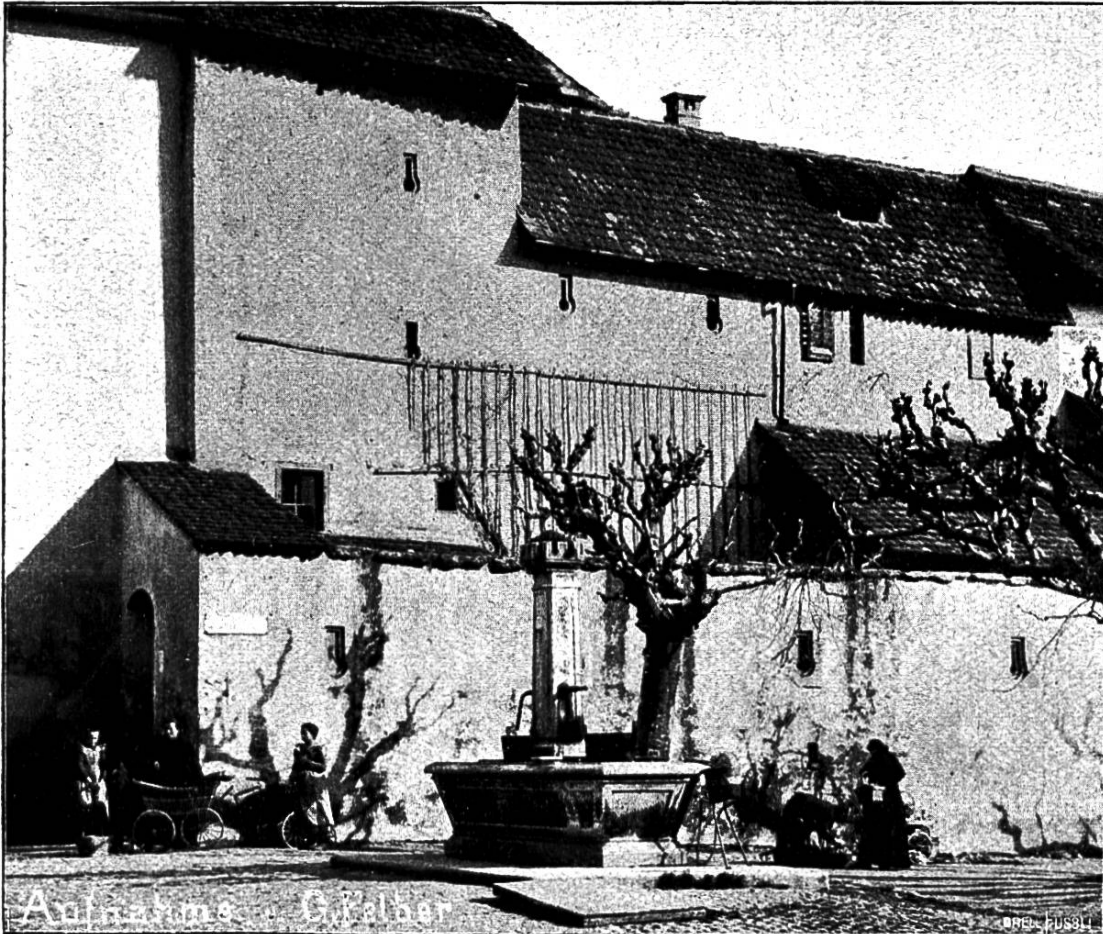
Alte Stadtmauer beim Eisi.
